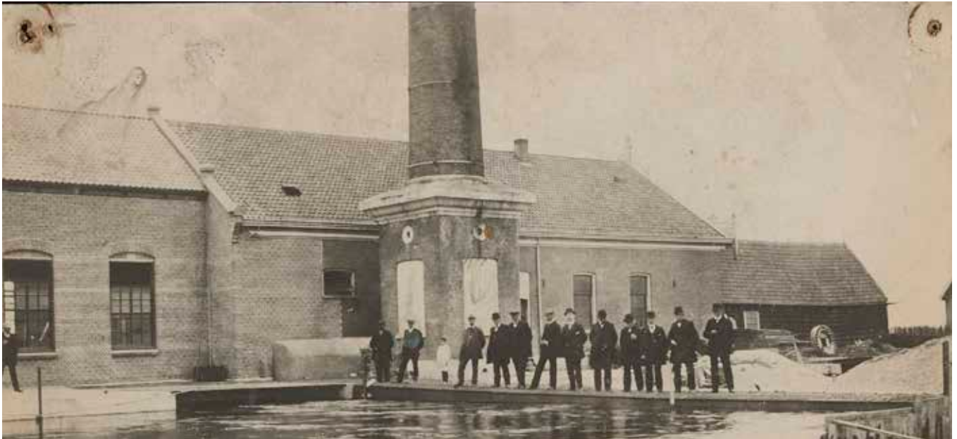
Het in 1877 gebouwde stoomgemaal, hier in circa 1935, is tegenwoordig het Poldermuseum (Bron: RAA)
