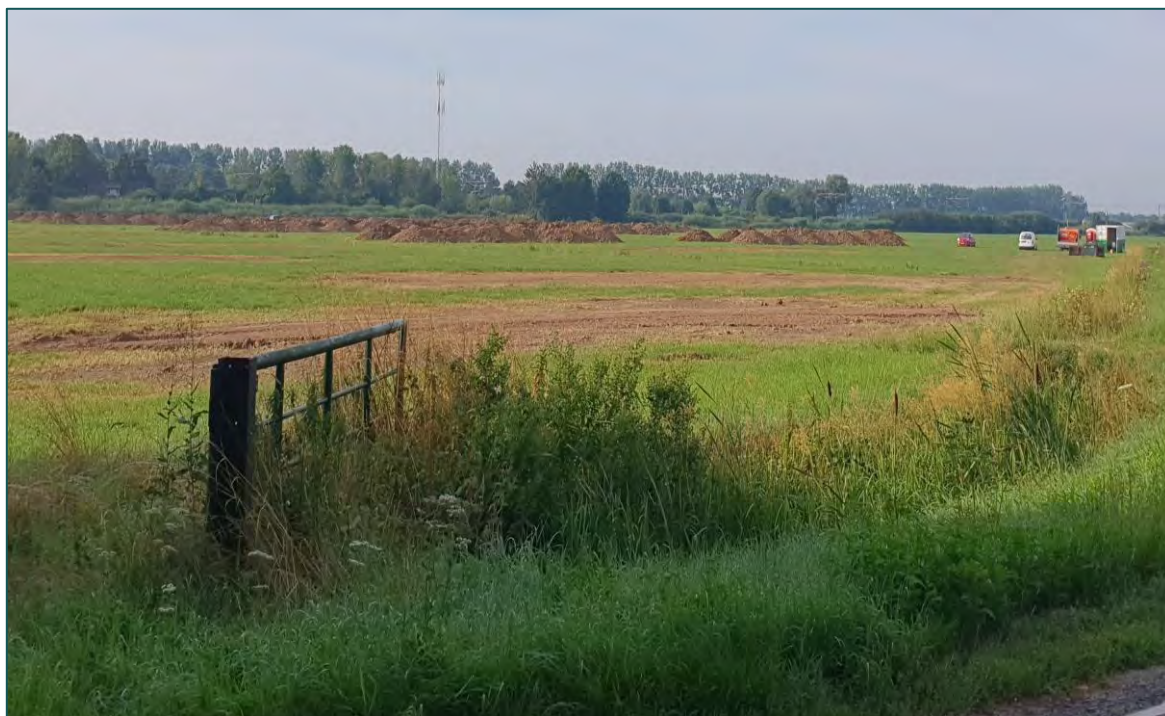
Figuur 2.5 De werkzaamheden tijdens het veldbezoek d.d. 21 juli 2023 op een van de weidevelden. Het betrof het realiseren van proefsleuven.
