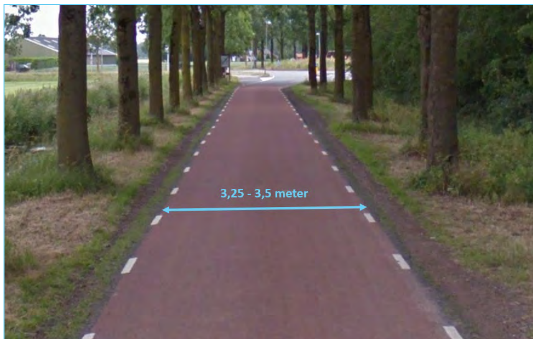
Figuur 4-1: Wegprofiel De Rijt
