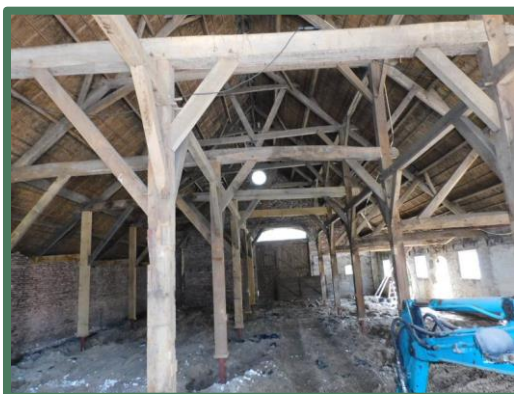
Binnenzijde monumentale schuur
