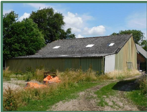
Achterzijde open loods
