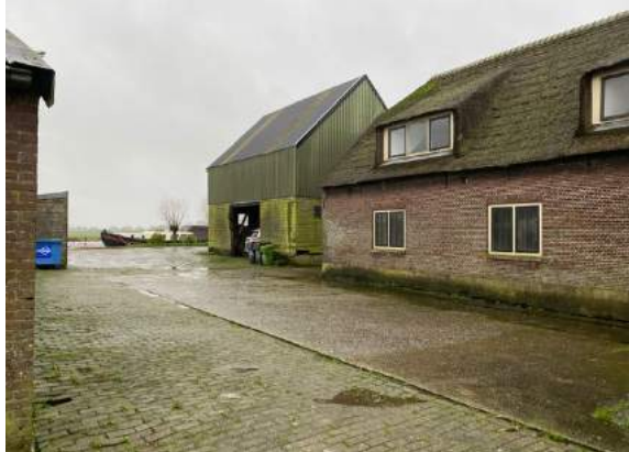
De nieuwe stal (links) De houten schuur (links achter) De hooiberg (midden)
