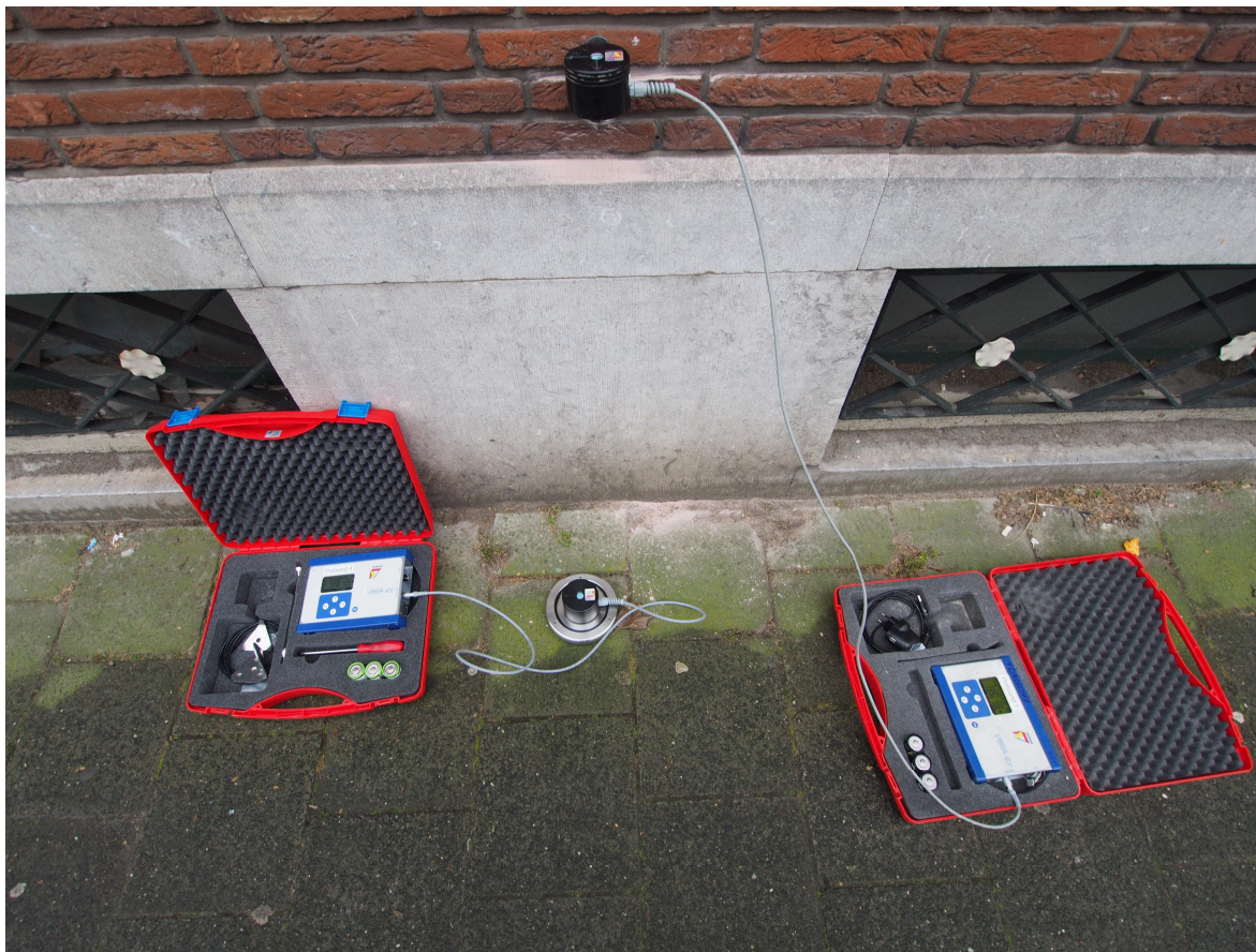
Meetapparatuur aan de gevel bevestigd en op de stoep geplaatst (Mathenesserlaan)
