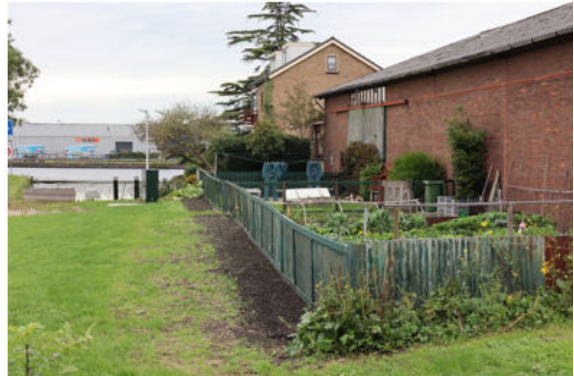
Achterzijde van de te slopen bedrijfsloods.
