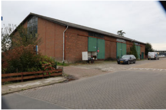
De te slopen bedrijfsloods.
