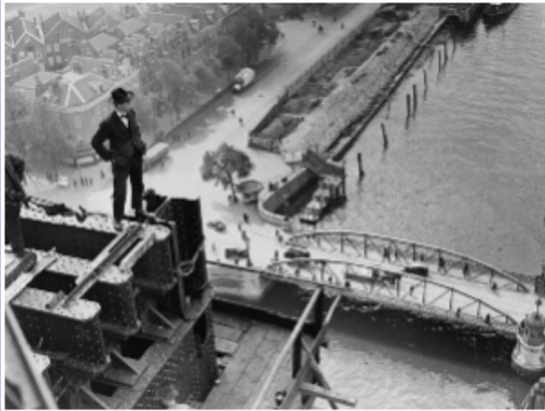
Koningshavenbrug 'De Hef'
