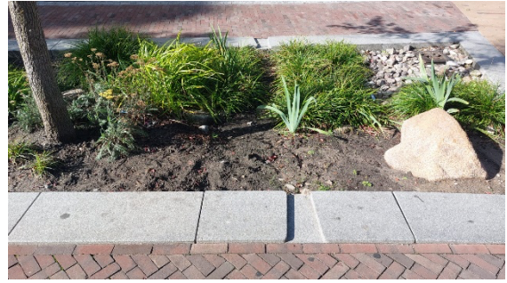
10 Ontwerp van het plein richt zich op het bergen van water zodat het regenwater kan infiltreren in de ondergrond. (Bron: eigen beeld)
