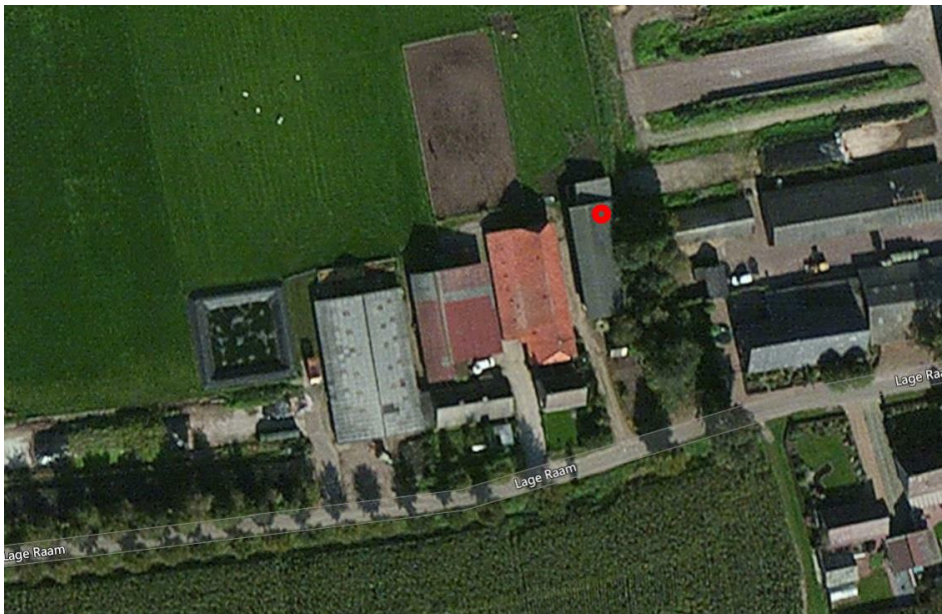
Afbeelding 4: Locatie steenuilenkast (rode cirkel) in de loods aan Lage Raam 6 (bron luchtfoto: Bing Maps).
