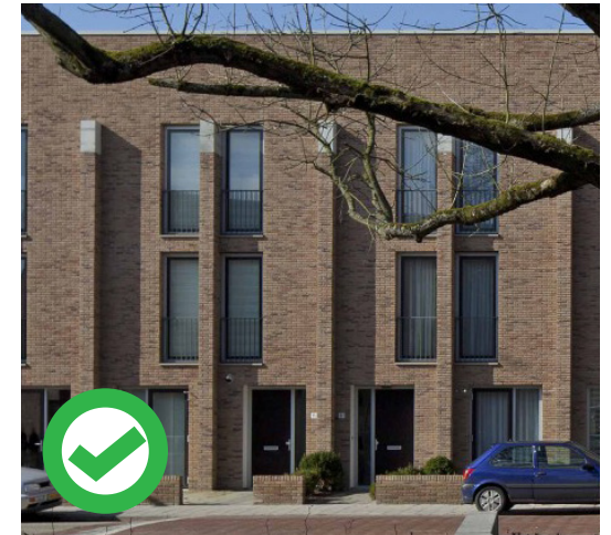
Verticale geleiding bij woningen
