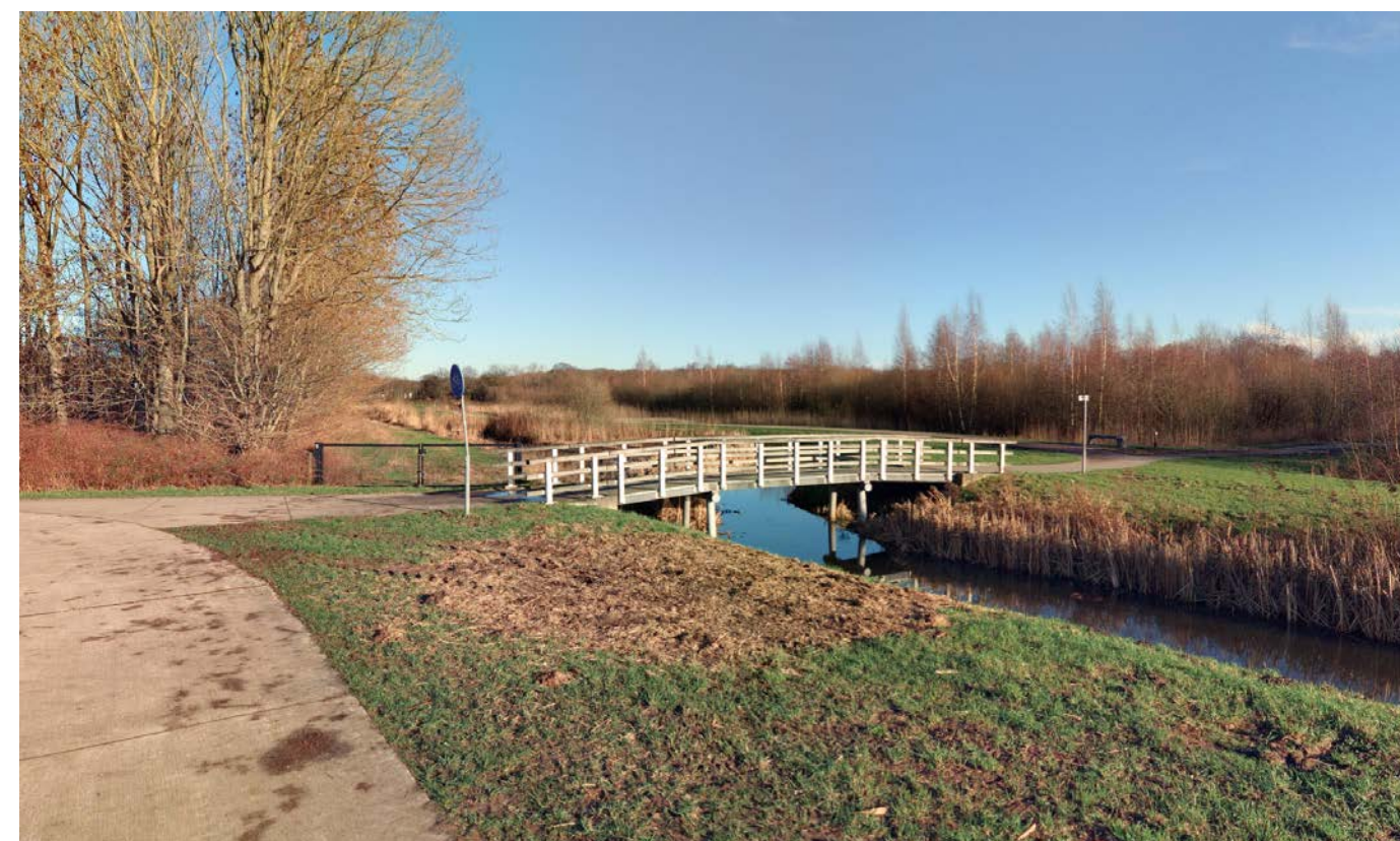
één van de bestaande bruggen over de Westerveldse Aa
