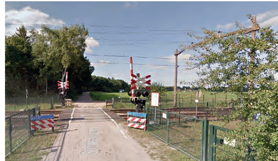
Spoorwegovergang Schoutse vennen
