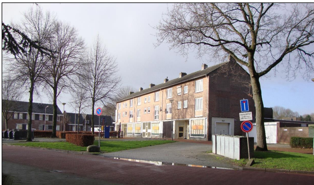
Portiekwoningen Bremstraat 2-22 (even huisnummers)
