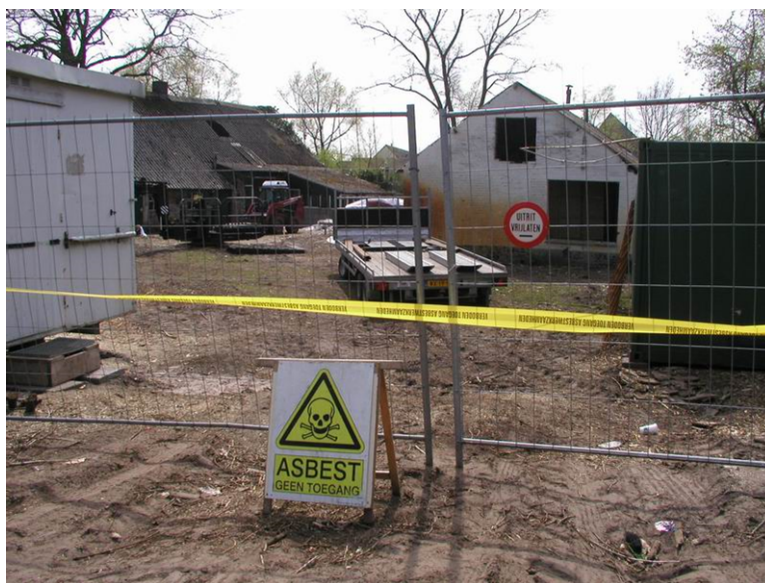
Figuur 4.11: Afscherming van een asbestverdachte locatie
