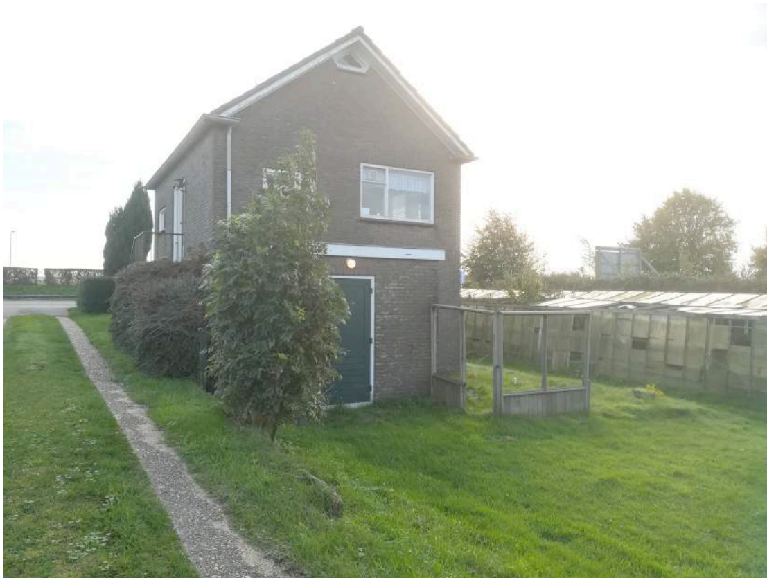
Het woonhuis aan de Hoekeindseweg 121 met links de onverharde weg en rechts de glastuinbouwkassen. Foto: [REDACTED], Ecoresult B.V.
