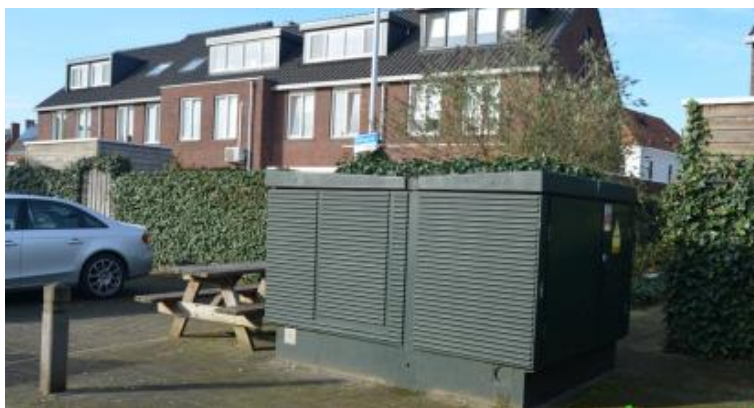
Figuur 4: Aanzicht van een MS/LS-station
