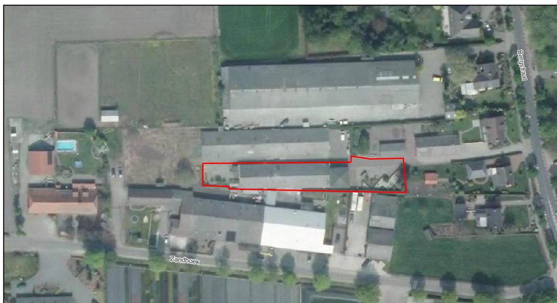
Figuur 20: Luchtfoto locatie Bergstraat 64A
