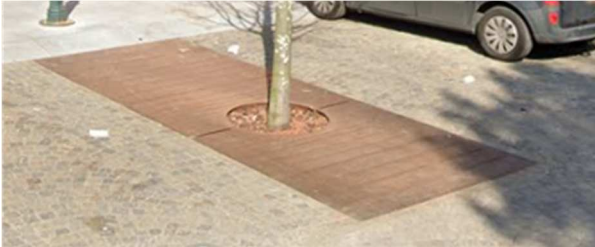
Foto: boomspiegel met plantgat voor boom. Hierop wordt de bak met boom geplaatst.
