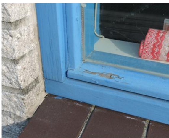
Foto C4 | Beschadigingen kozijnen en raamdorpelstenen
