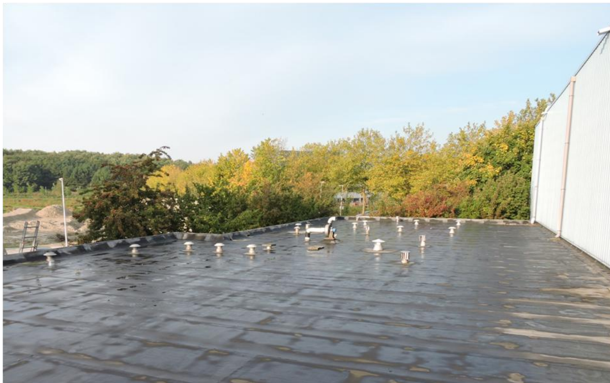
Foto C9 | daktoevoeren en afvoeren op de laagbouw
