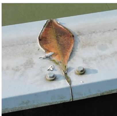
Foto's C2 | Diverse corrosieschades metalen geveldelen.
