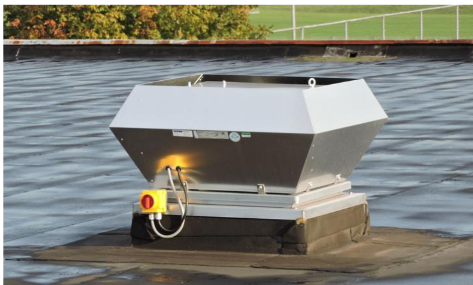
Foto C13 | De nieuwe (lawaaaiige) afzuigventilatoren van de sporthal
