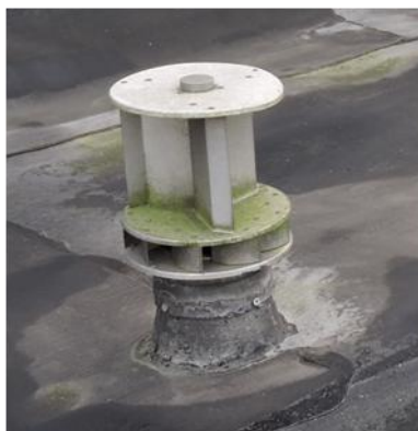
Foto C8 | huidige luchttoevoer/afvoervoorzieningen dak laagbouw.
