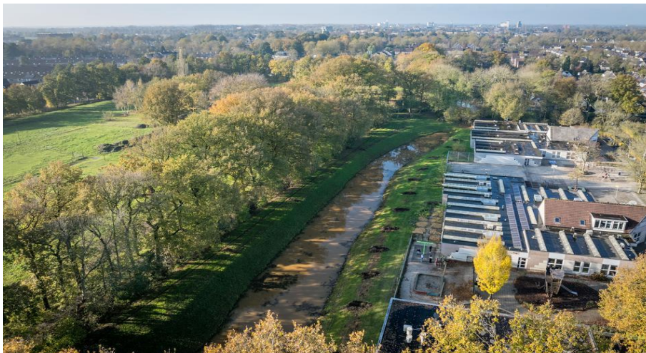
Bestaande sloot/watergang met talud
