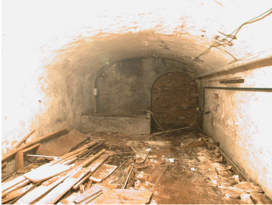
Kelder, foto genomen in 2002. Bron: Bouwhistorische verkenning 2002.
