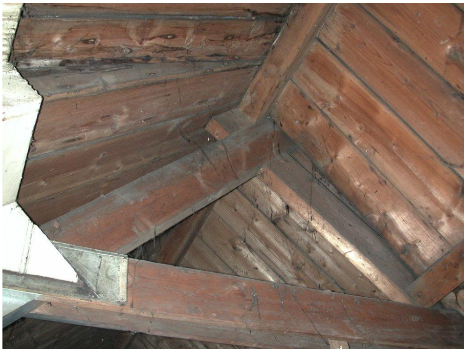
Kapconstructie, foto genomen in 2002. Bron: Bouwhistorische verkenning 2002.
