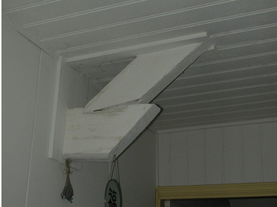
Aansluiting kapconstructie op afgezaagde zolderbalklaag, foto genomen in 2002. Bron: Bouwhistorische verkenning 2002.
