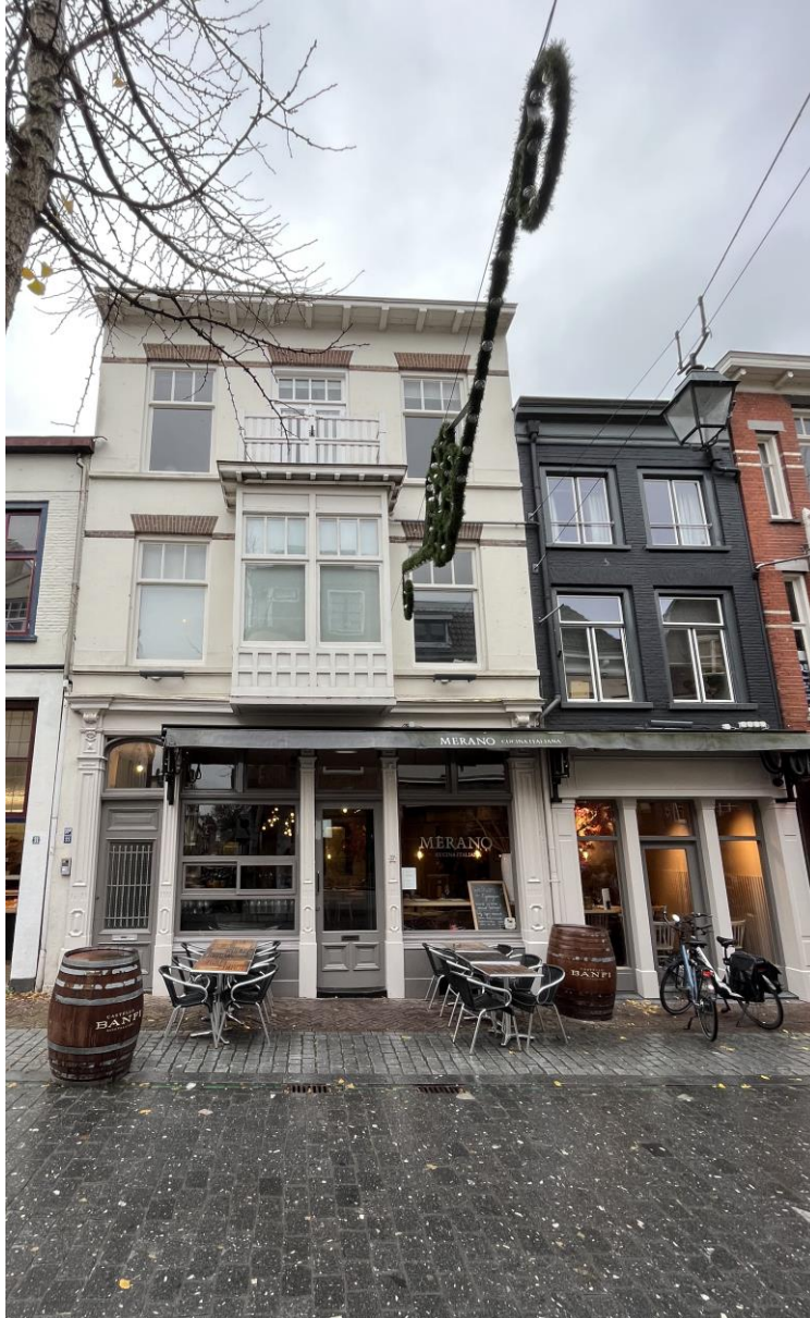
Voorgevel van de Lange Hezelstraat 33-33a (links) en 35 (rechts).
