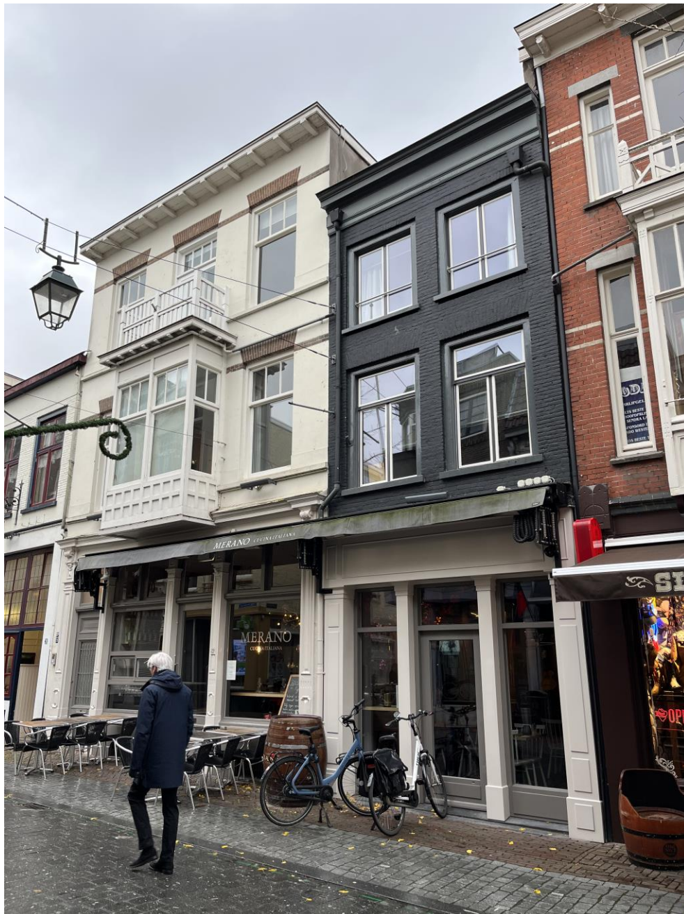
Voorgevels van de Lange Hezelstraat 33-33a (links) en 35 (rechts)
