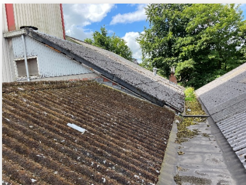
Overzicht asbesthoudende golfplaten daken
