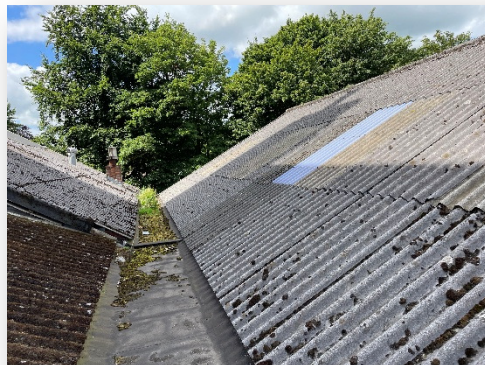
Overzicht asbesthoudende golfplaten daken
