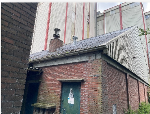
Overzicht golfplaten dak M3
