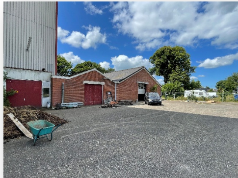
Opslagruimtes met golfplaten daken
