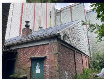
Bron M3 Buiten RK 2A Golfplaat dak fabriek en afdak Totaal 70 M 2
