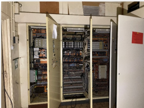
Installaties niet verdacht
