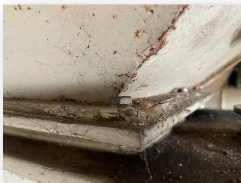
Installaties in silo en doseerruimte bevatten geen pakkingen
