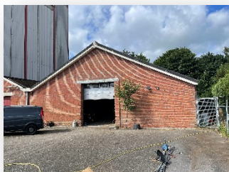
Bron M1 Buiten RK 2A Golfplaat dak Totaal 450 M 2
