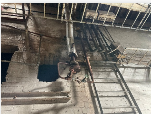
Isolatiemateriaal om leidingwerk niet verdacht
