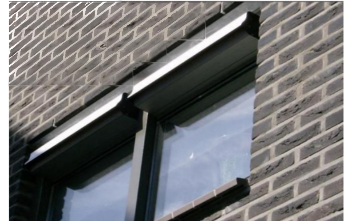
Voorbeeld suskast in gevel
