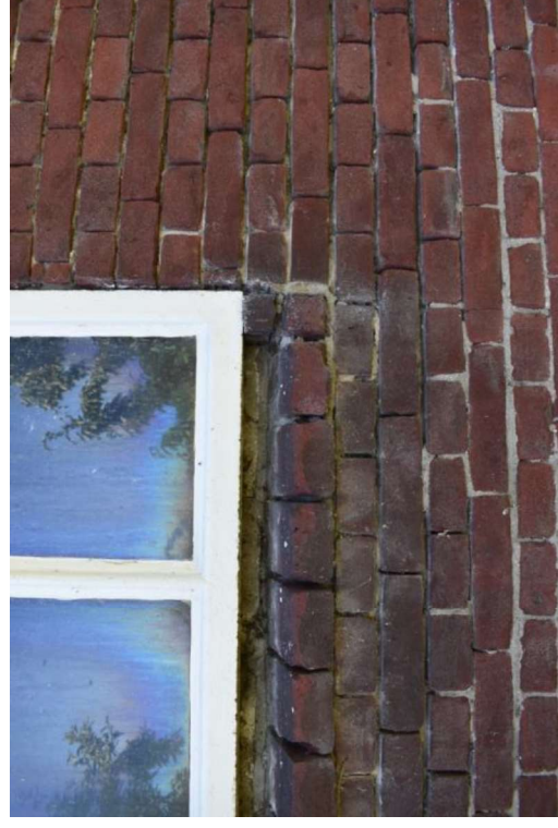
Bakstenen dorpel onder getoogd betonnen zesruits stalvenster.
