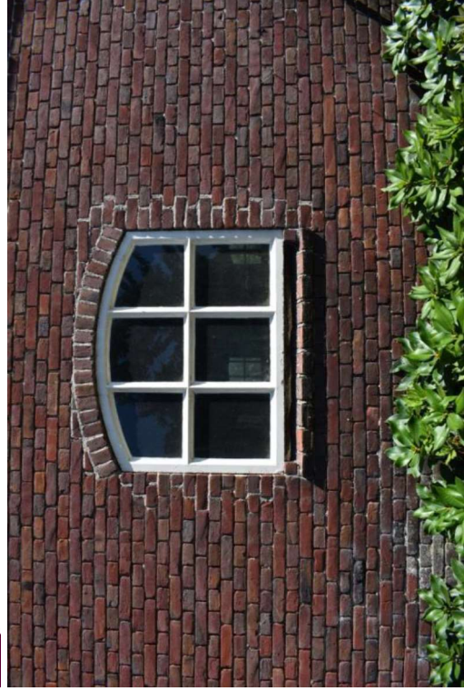
Getoogd zesruits betonvenster onder rollaag met bakstenen raamdorpelstenen.
