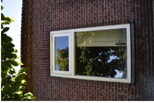
Vernieuwd houten venster met bovenlicht (rechts).
