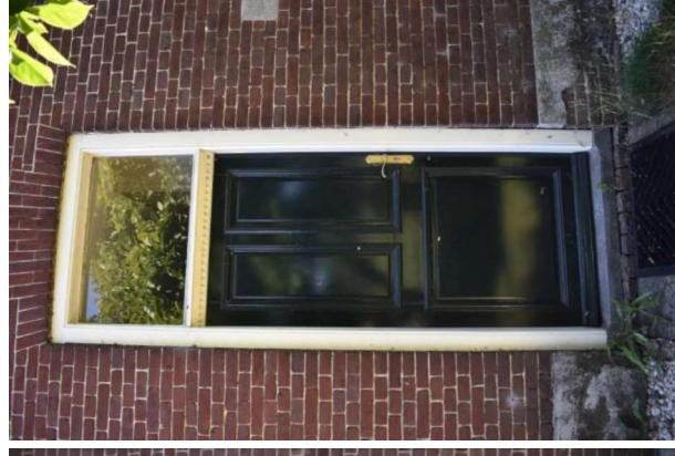
Voordeuropening met later toegevoegde deur.
