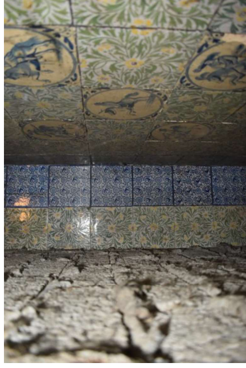
Tegels vermoedelijk uit 1904, geplaatst onder de schoorsteenboezem.
