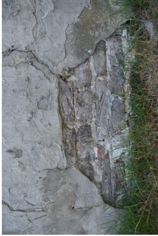
Gecementeerde plint met daarachter de bakstenen gevel.
