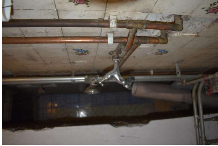
Tegels uit vermoedelijk 1904 geplaatst onder de schoorsteenboezem (aan de achterzijde) en tegels uit vermoedelijk de tweede kwart van de twintigste eeuw (aan de voorzijde).
