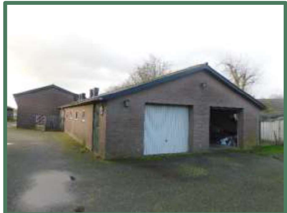
Te behouden garage en kapschuur
