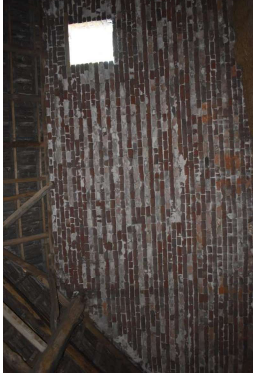
Rechterzijgevel vanuit het interieur gezien.
