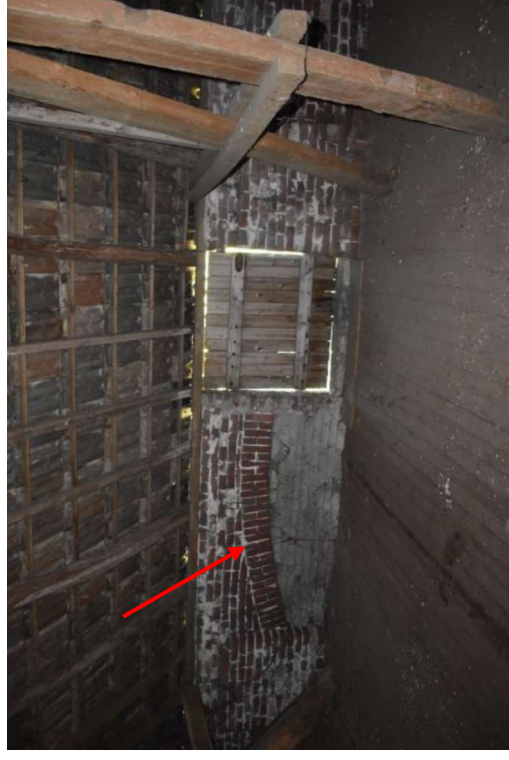
De rode pijl wijst de rollaag en opening van de voormalige dwarsdeeldeur aan.
