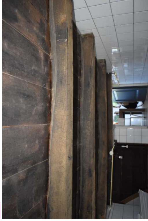
Kelder met balkenconstructie vermoedelijk uit 1904.
