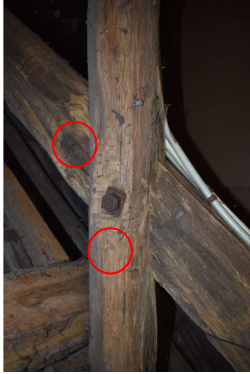
Verbinding door middel van een bout en moer. De rode cirkels wijzen het telmerk in de vorm van een halve maan aan.
