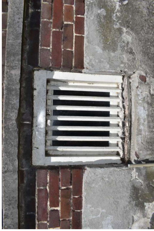
Kelderraam onder de opkamer.
