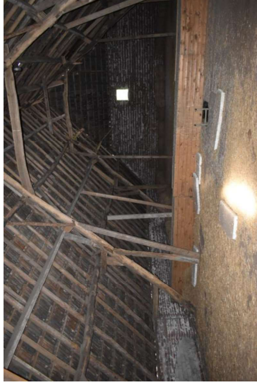
Twee achterste spanten richting de rechterzijgevel gezien.
