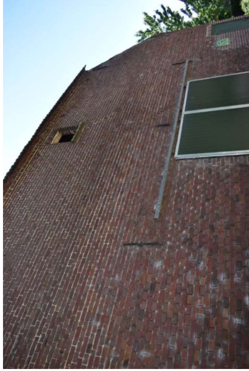
Raamopening op de eerste verdiepingvloer.
