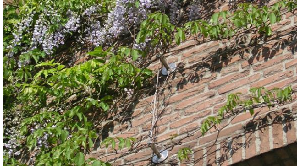
Voorbeeld van bevestiging tbv klimmers aan de gevel
