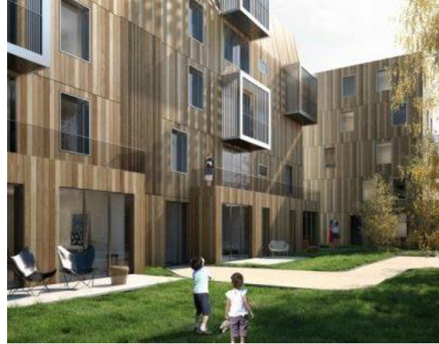
Geleding van gevel d.m.v. uitkragende bloemramen
