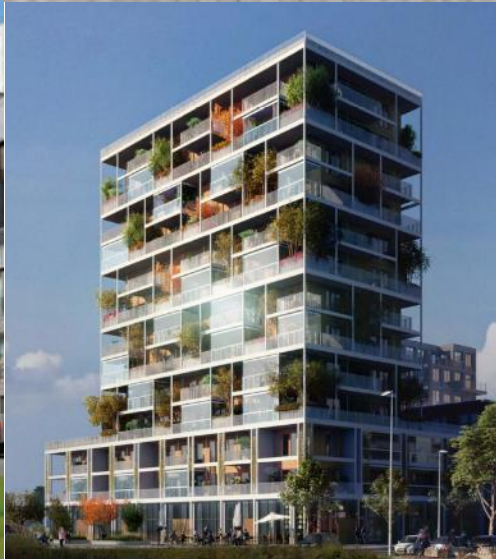
Referentiebeelden voor woongebouw Victoriapark. Dit is een voorbeeld van relatief eenvoudige bouwconstructie met een zelfdragende balkongevel. Deze is ingevuld met groenelementen over meerdere verdiepingen.
