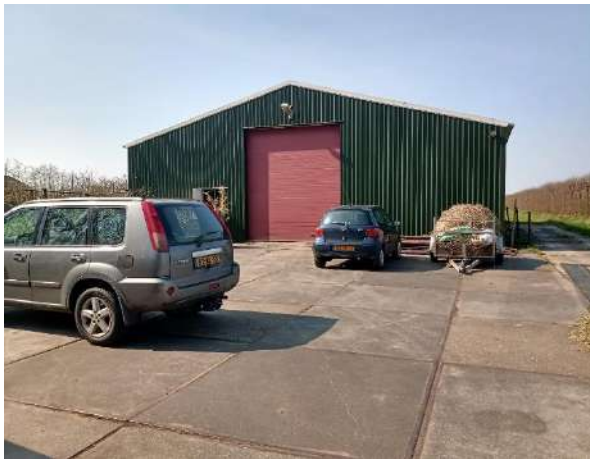
Figuur 3. Bestaande schuur met betonplaten
