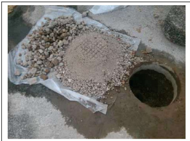
Foto 3. Opgegraven en gezeefd materiaal inspectiegat 08A
