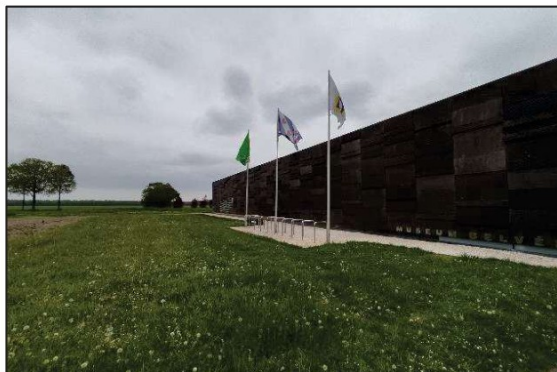
Afbeelding 2.2. Voorzijde van het gebouw.
