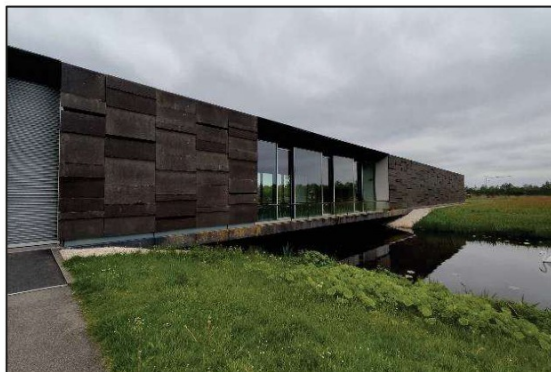
Afbeelding 2.3. Achterzijde van het gebouw.
