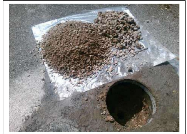
Foto 2. Opgegraven en gezeefd materiaal inspectiegat 07A
