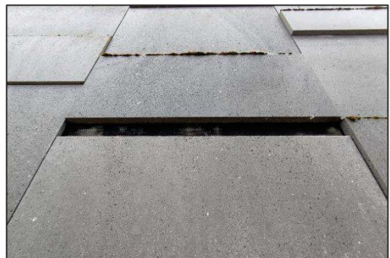
Afbeelding 3.2. Ruimte tussen stenen en muur.
