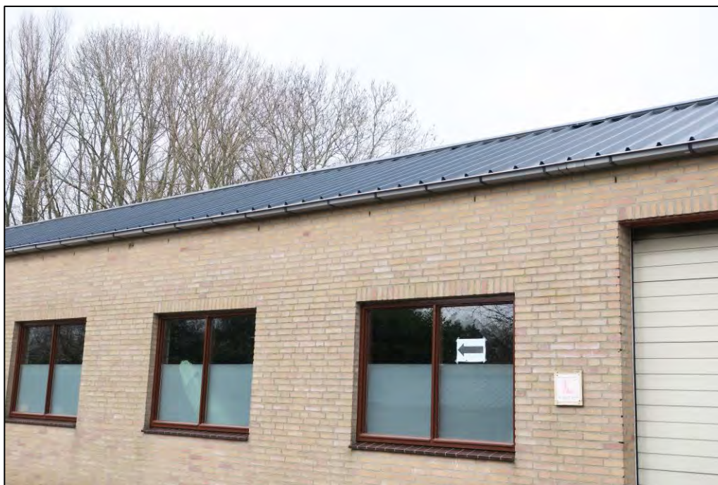
Figuur 1 De zuidgevel.
