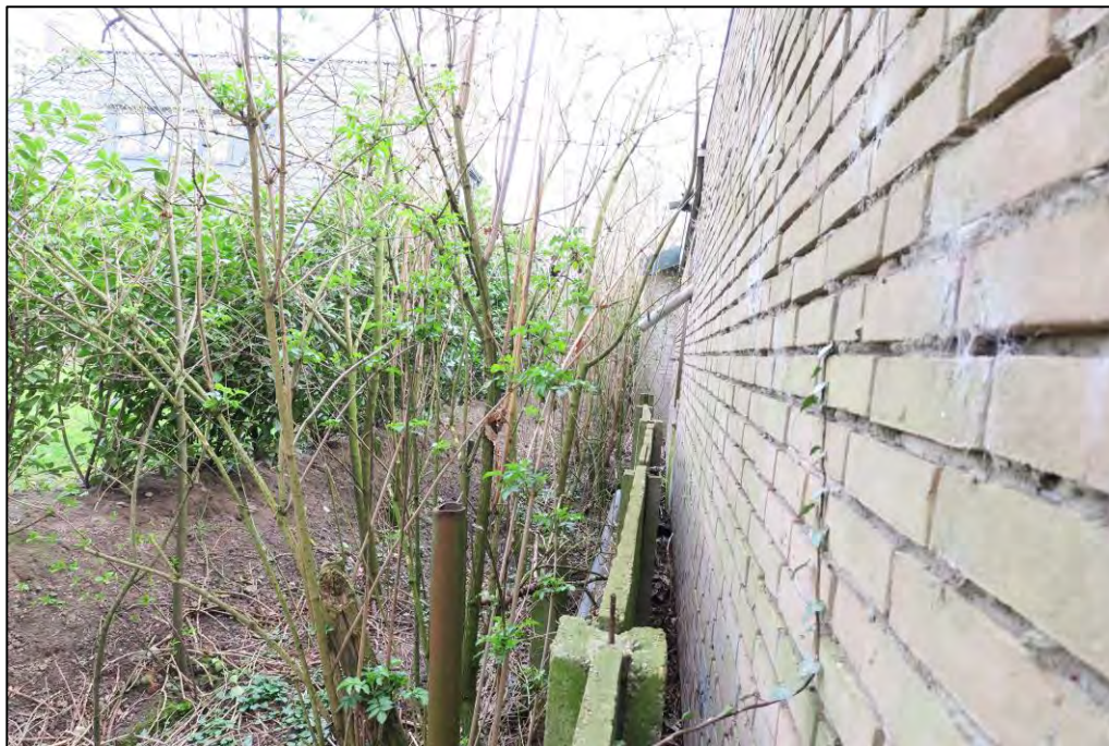
Figuur 2 De noordgevel ligt tegen de groenstrook aan.
