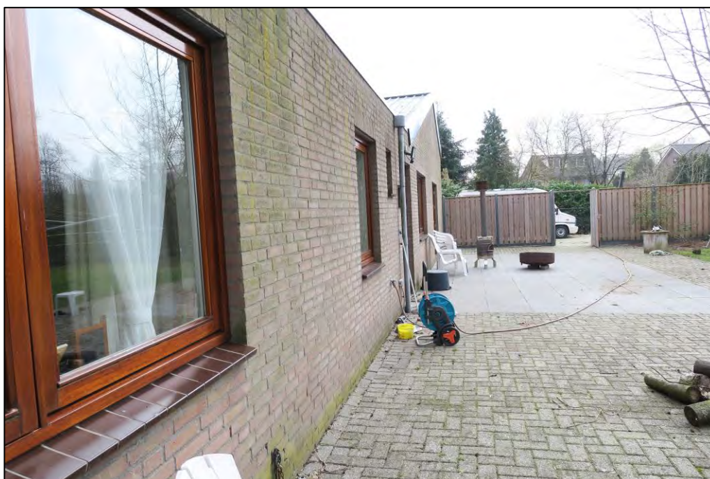
Figuur 3 De westgevel.
