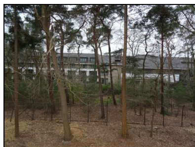
Figuur 9. Hotel Van der Valk en strook Natura 2000, gezien vanaf zanddepot.
