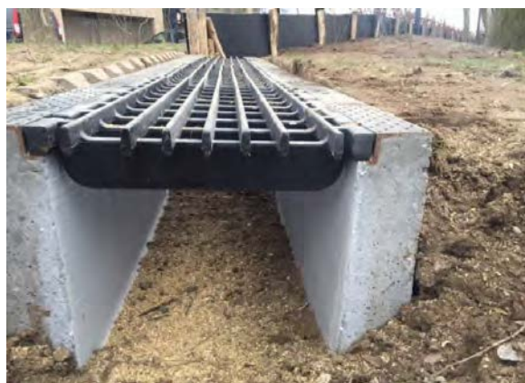
Figuur 6-4. Voorbeeld faunatunnel (Faunaconstruct, 2022).
