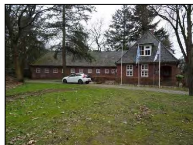
Figuur 5. Gebouw aan westzijde van de onderzoekslocatie.
