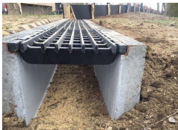
Figuur 6-4. Voorbeeld faunatunnel (Faunaconstruct, 2022).
