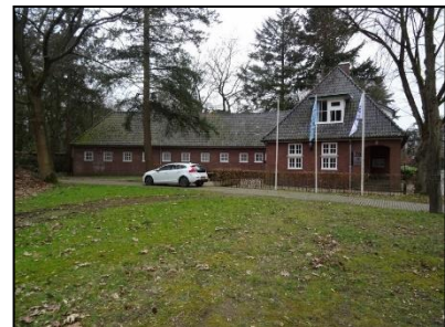
Figuur 5. Gebouw aan westzijde van de onderzoekslocatie.
