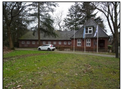
Figuur 5. Gebouw aan westzijde van de onderzoekslocatie.
