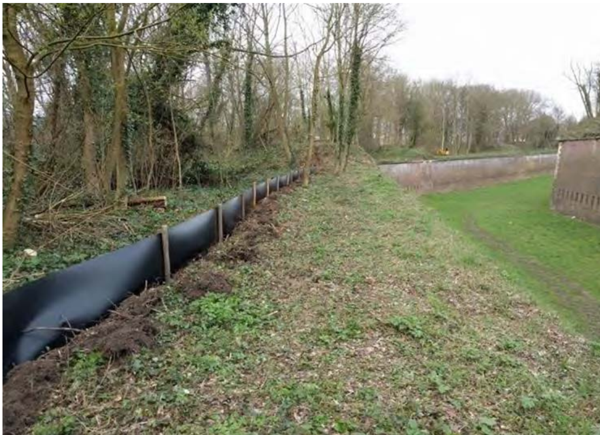
Figuur 6-1. Voorbeeld geplaatst reptielenscherm (Ranox, 2020).
