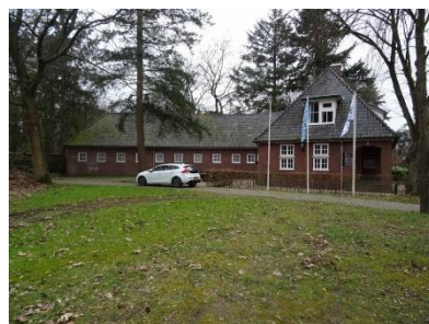
Figuur 2-5. Gebouw aan westzijde van de onderzoekslocatie.
