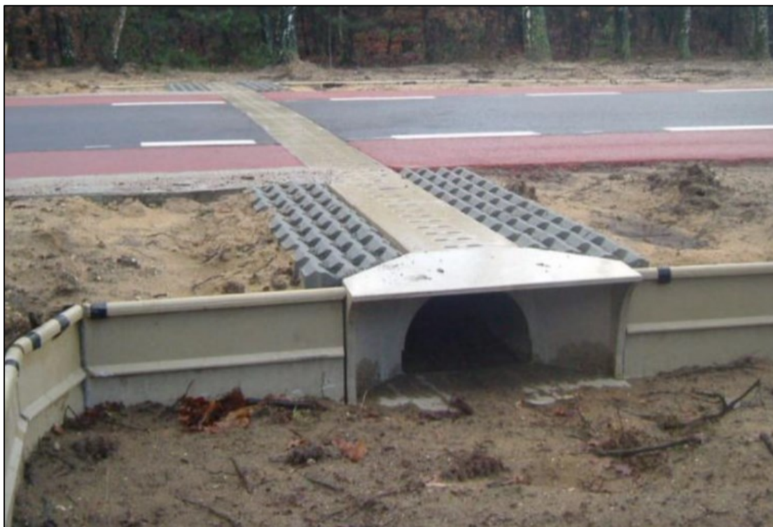
Figuur 3. Een voorbeeld van de te realiseren faunapassage onder de nieuwe aan te leggen ontsluitingsweg. De weg wordt omheind door 40 cm opstaande verticale betonblokken, zodat hazelworm en andere reptielen/kleine zoogdieren de weg niet op kunnen en mogelijk als verkeersslachtoffer vallen.
