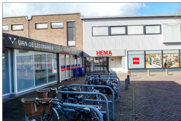
Van Tijnplein potentiële locatie service-stalling
