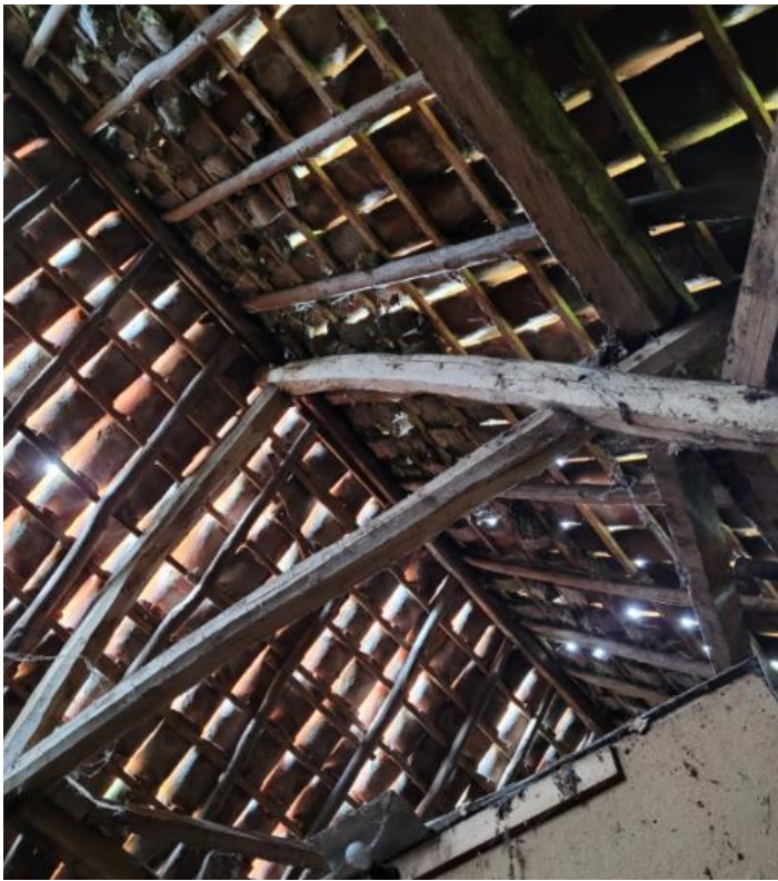
Afb. 3.5 De kapconstructie van Boerderij Vogelenzang (BOEi, 2023)
