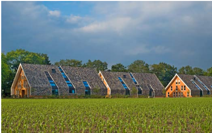
Afb. 3.57 Langgevelboerderijen met meerdere rijwoningen, Uddel Beltman Architecten
