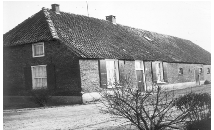
Afb. 3.61 Afgebroken pachtboerderij Boort 1
