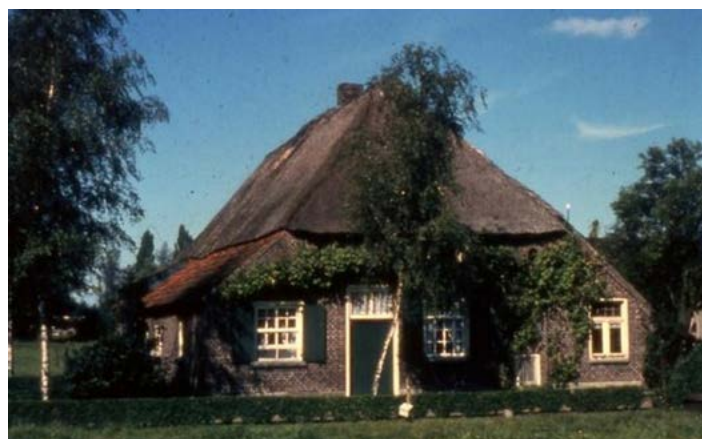
Afb. 3.55 Afgebroken pachtboerderij 't Slotje
