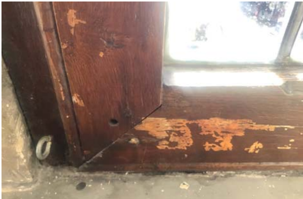
46.5 verspreid beschadigd schilderwerk binnenzijde
