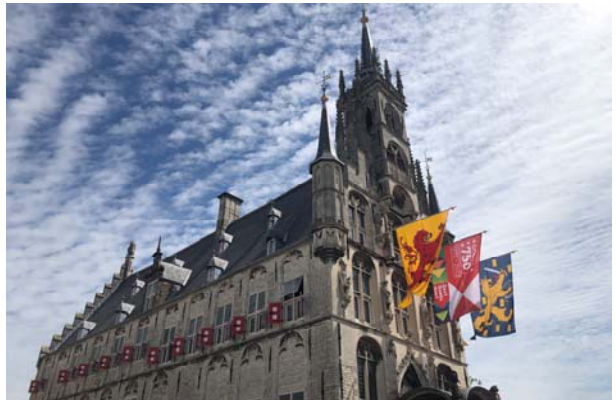
Zicht op de gevels noord en west
