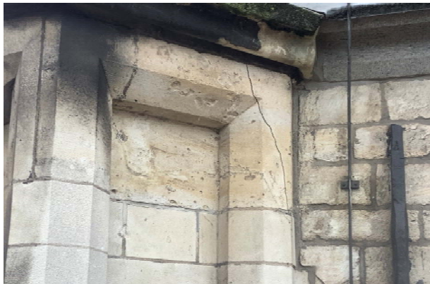
35.2 scheurvorming hoektorens
