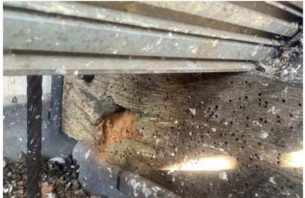
24.2 sterk aangetaste klokkenstoel (houtbor. insect)
