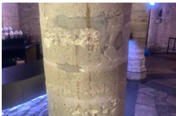
35.7 voegen in harde cementmortel souterrain
