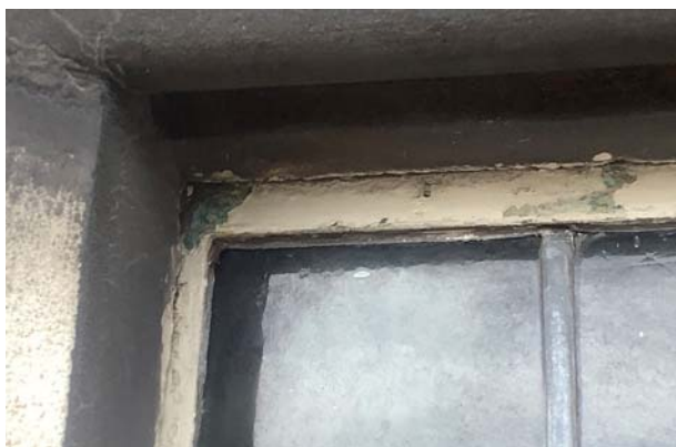
30.1 bronzes kozijn, zit los en voegvulling ontbreekt
