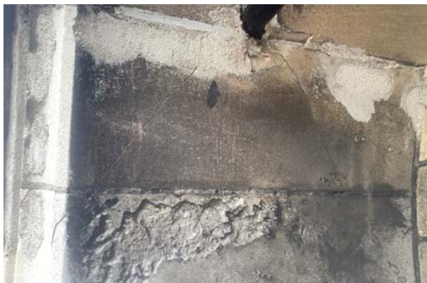
35.5 scheur in natuursteen onder balkon
