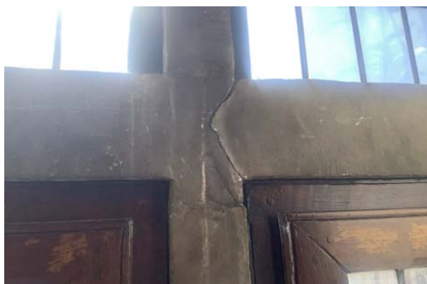
35.11 verspreid zijn dorpels en kalven gebroken
