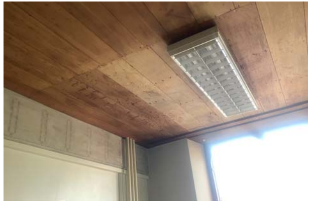
46.5 Plafond met houten delen zonder afwerking
