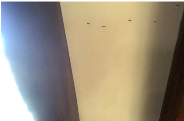
45.6 verspreid houten delen opnieuw bevestigd
