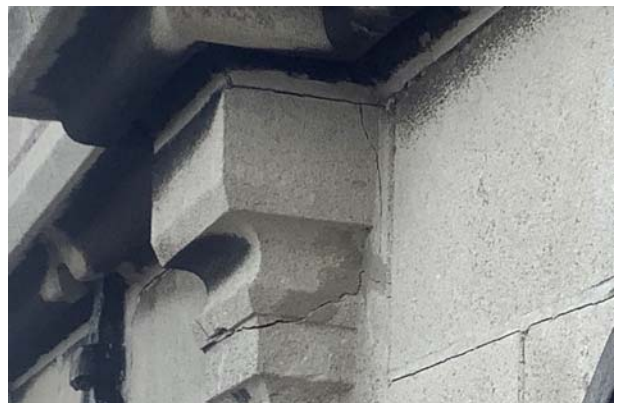
35.5 scheur in console onder balkon
