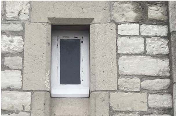
46.3 afgebladderde verf raampje oostgevel
