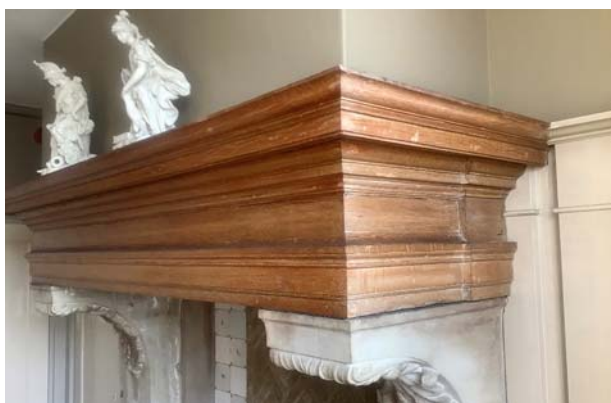
45.2 betimmering met zeer schrale afwerking
