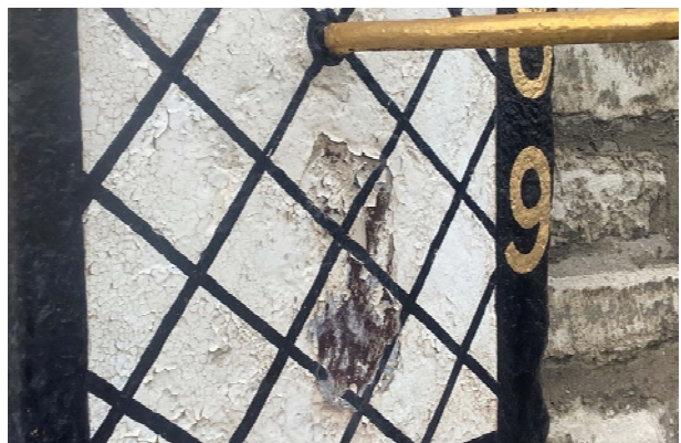
46.3 afgebladderd schilderwerk zonnwijzer
