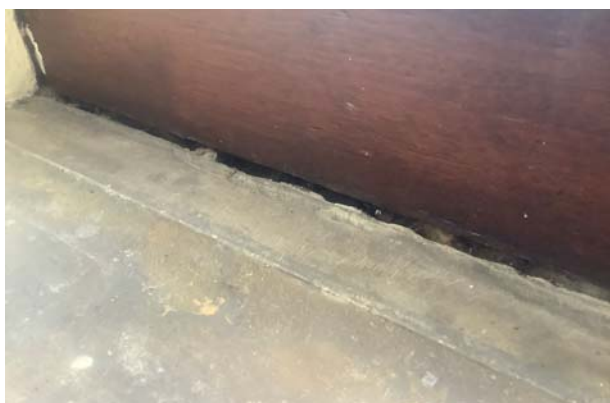
36.2 kier tussen natuursteen en houten kozijn
