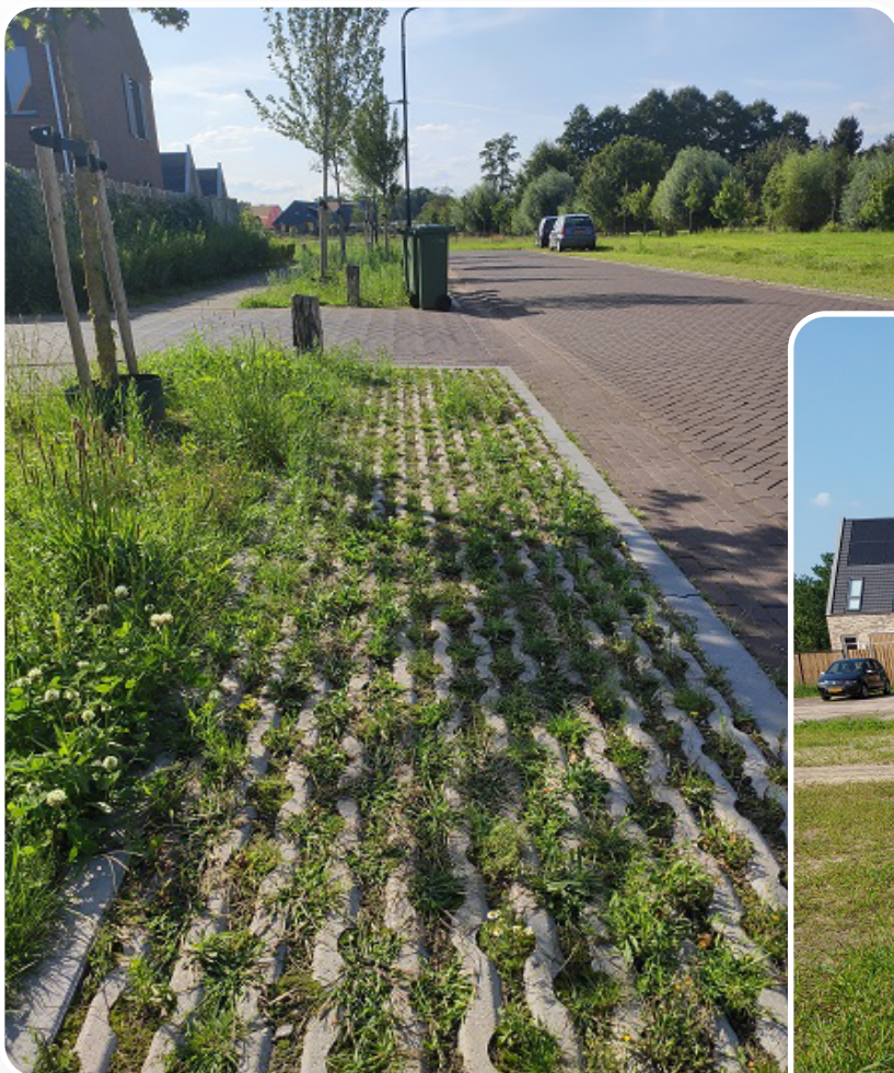
Afbeelding 17: Containeropstelplaats in grasverharding
