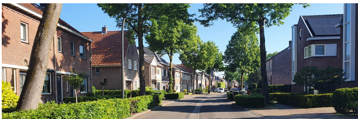
Afbeelding 227. Gevarieerde bebouwing en afwisselende rooilijn.
