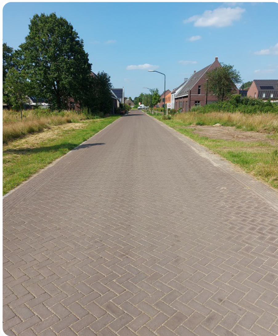
Afbeelding 3: Rijbaan lint buiten clusters
