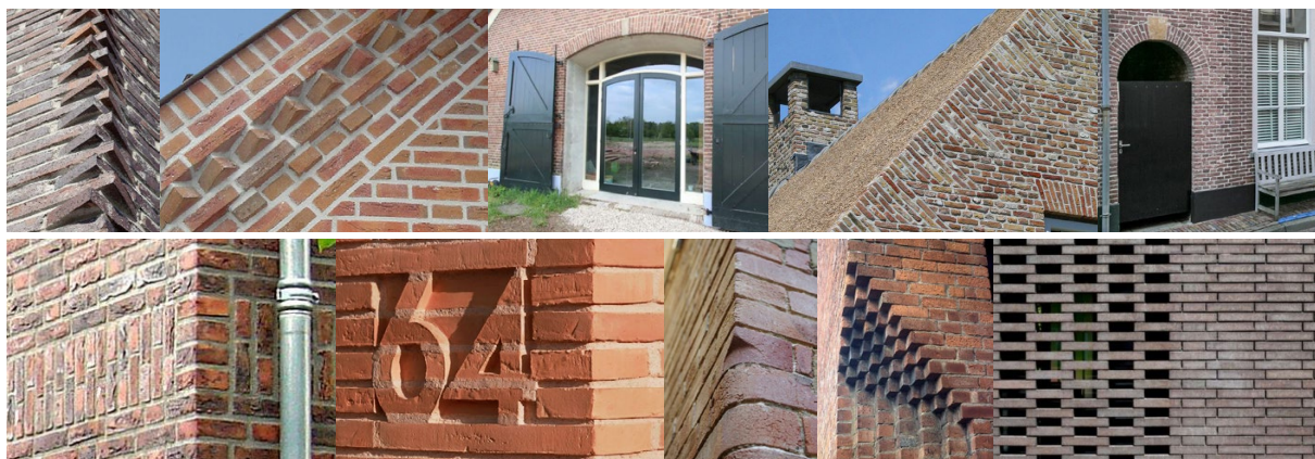
Afbeelding 241. Verbijzondering door zorgvuldig gedetailleerde gevels.
