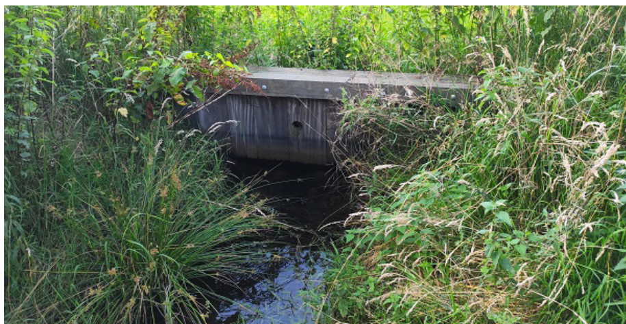
Afbeelding 24: Houten dam dienend als overstortconstructie naar waterschapssloot
