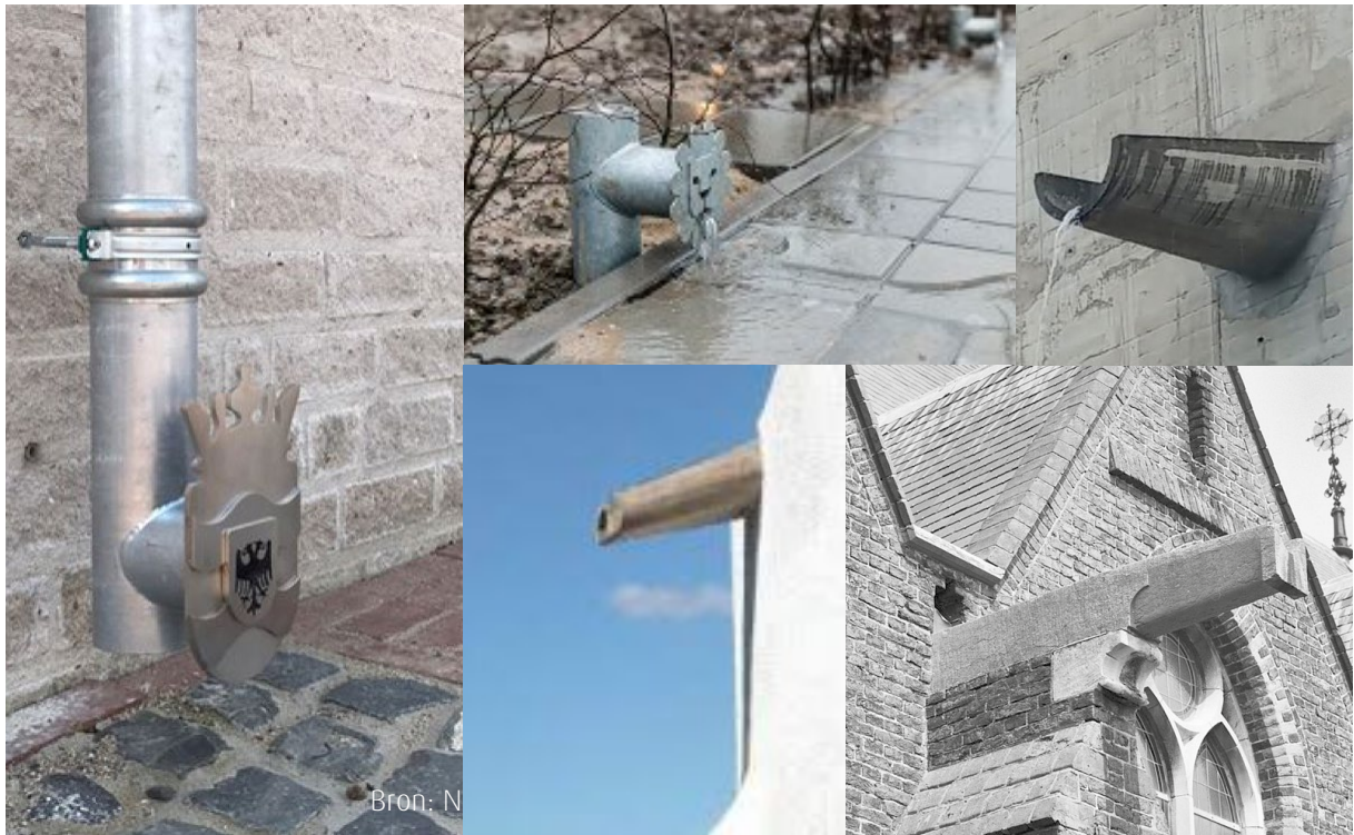
Afbeelding 212. Voorbeelden van zichtbaar afwateren.
