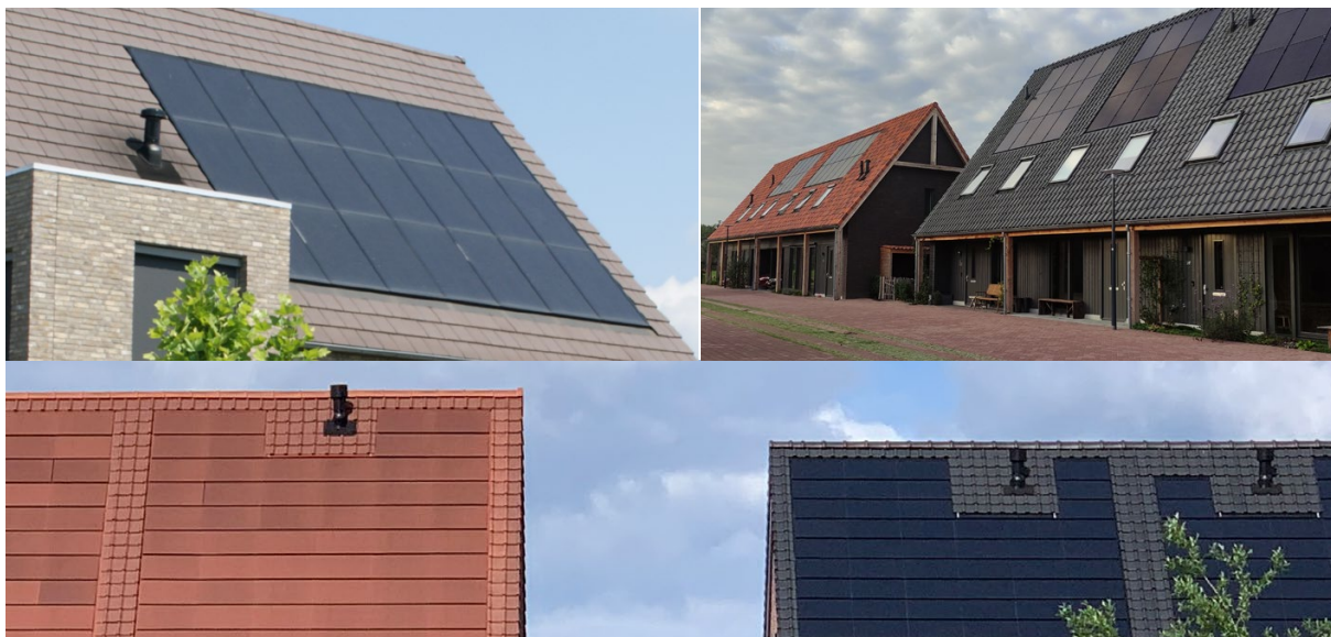
Afbeelding 53. Voorbeelden van zonnepanelen in het dakvlak.
