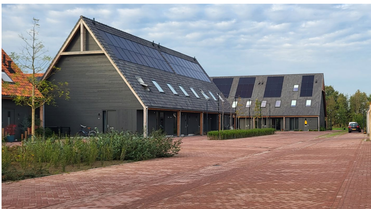
Afbeelding 106. Zonnepanelen, dakramen en andere dakelementen worden mee-ontworpen met het dakvlak.
