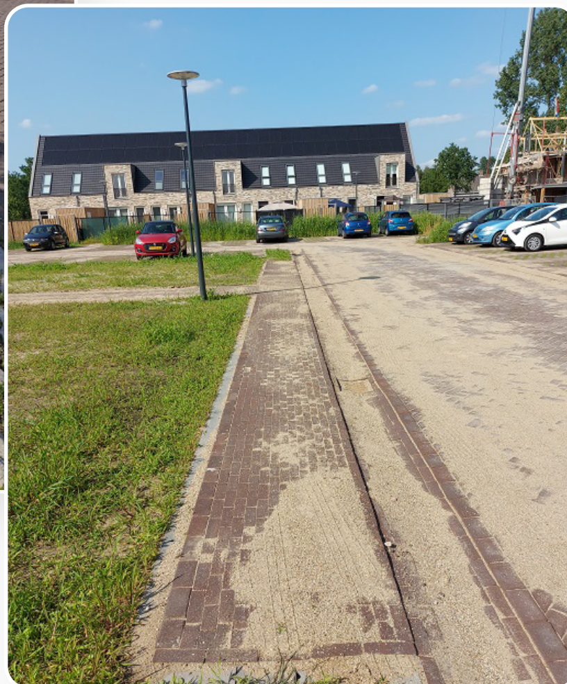
Afbeelding 18: Containeropstelplaats in gebakken verharding
