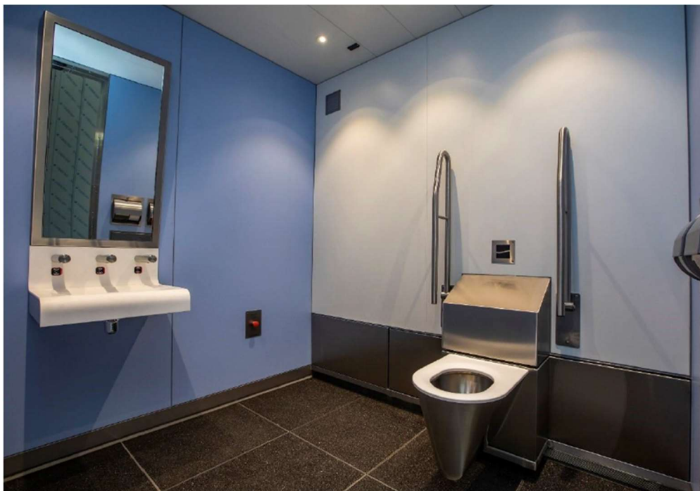
Foto: Inrichting van een zelfreinigend mindervalide toilet
