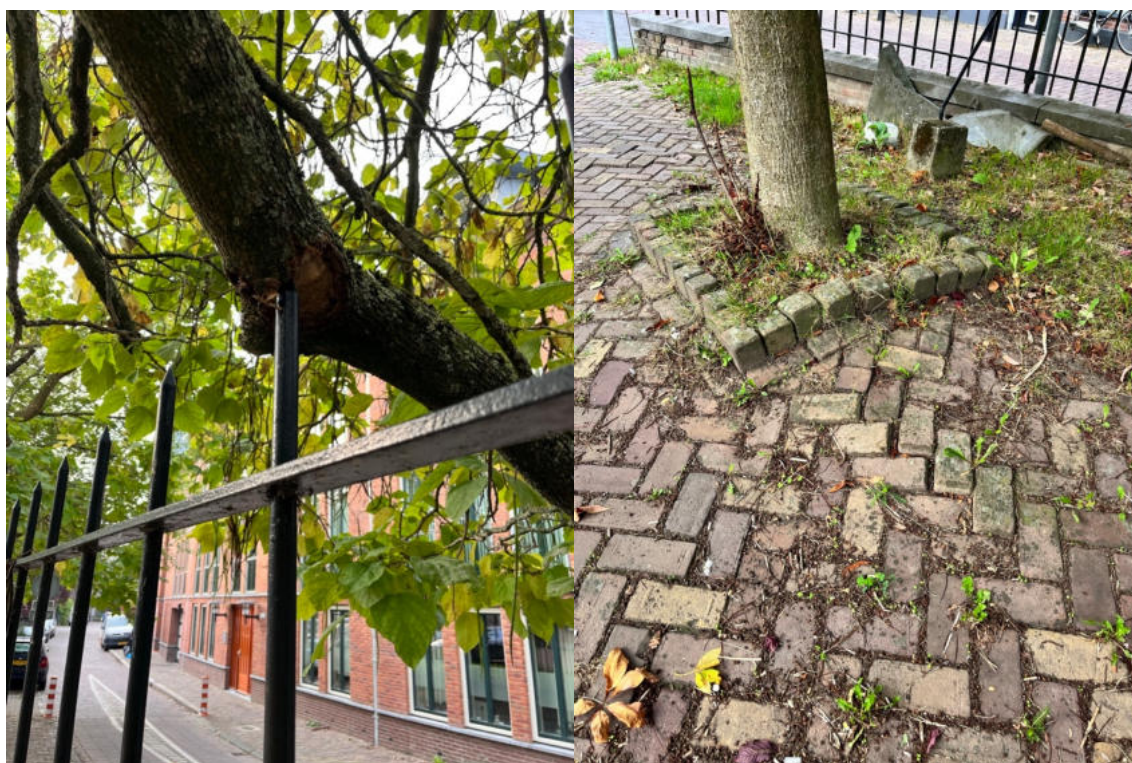
Laaghangende takken van Catalpa leunen op het hek. (boom 17) Te kleine boomspiegels kan tot wortelopdruk leiden. (boom 11)
