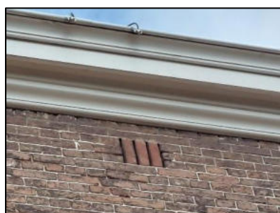
Figuur 6. Ontluchtingsgaten in de muren van het gebouw.
