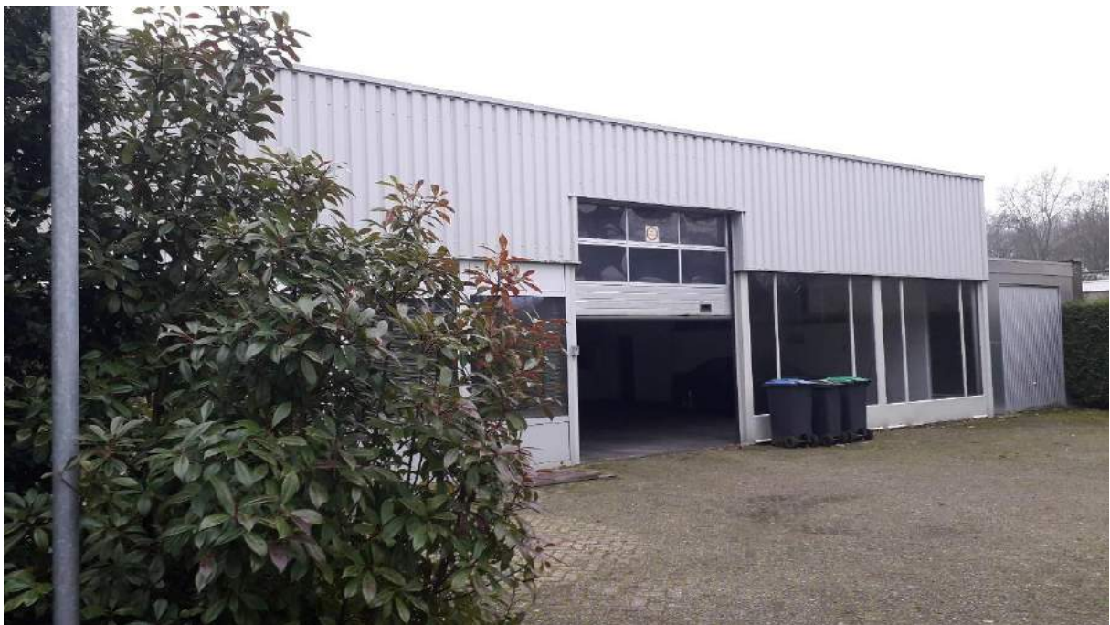
De zuidelijke garagehal achter het hoofgebouw. De garages bestaan vrijwel geheel uit damwandplaten
