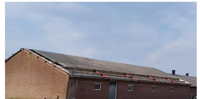
Figuur 9: Deels verwijderd dak
