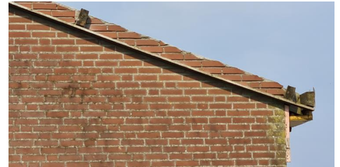
Figuur 6: Detailopname dakrand
