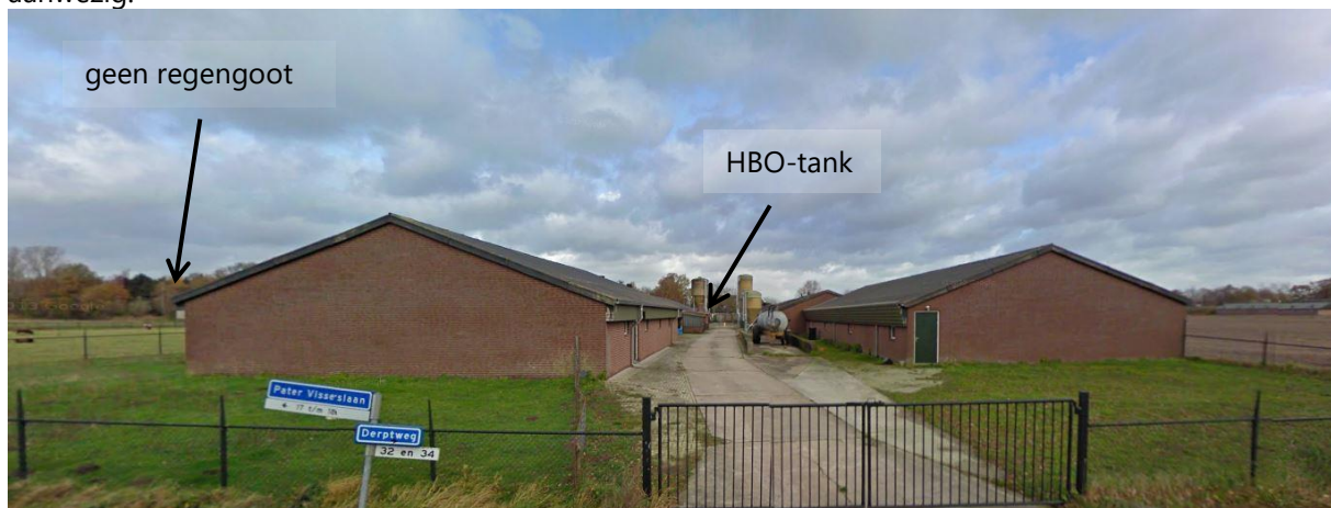
foto: zuidoostelijk deel onderzoekslocatie
