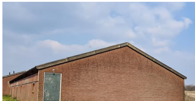
Figuur 8: Detailopname dakrand
