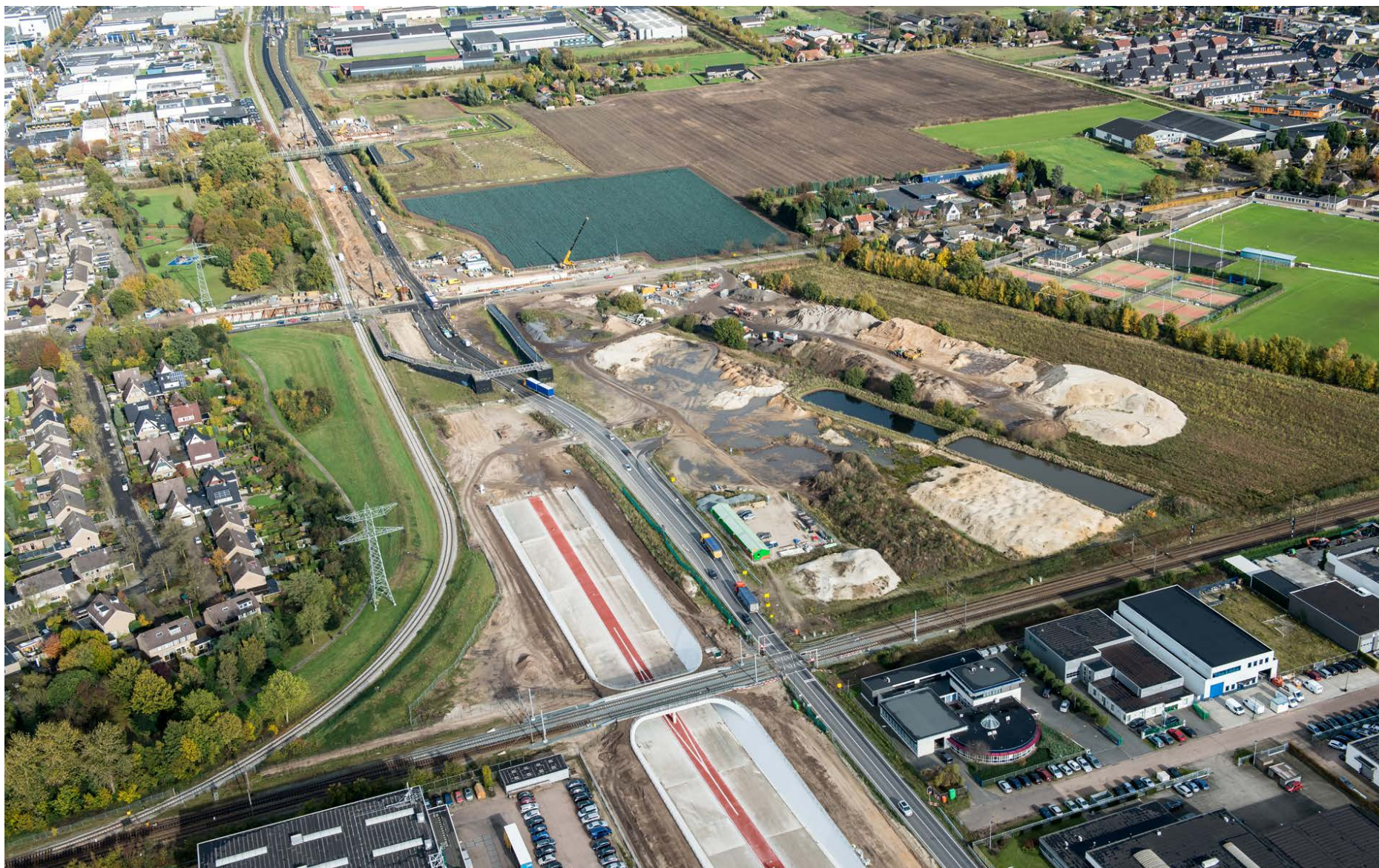
Foto: 5.12e ; Aanleg N329 2012
