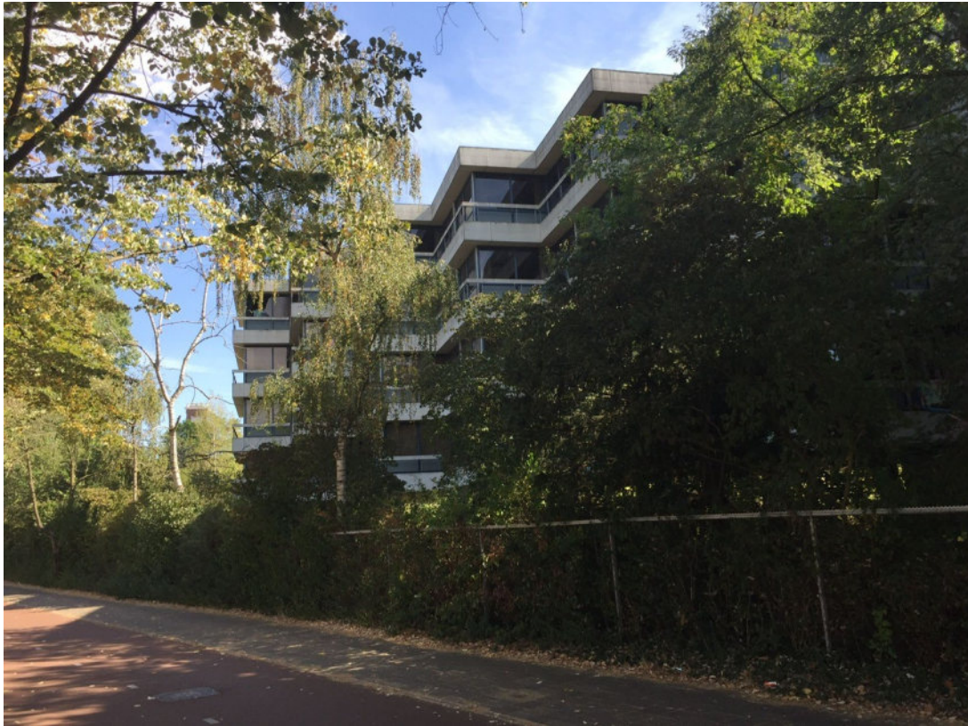
Figuur 6. Aanzicht voormalig UWV-kantoor vanaf Tunnelweg.
