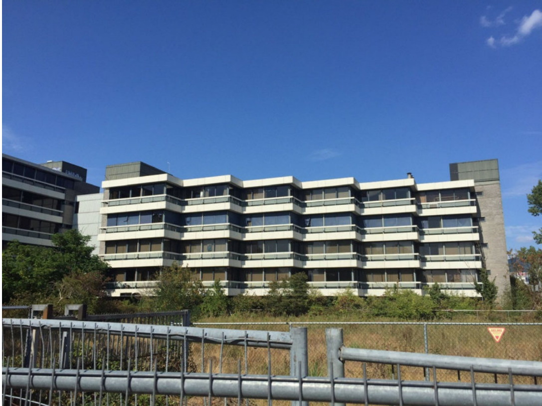
Figuur 3. Plangebied vanuit zuid-oosthoek gezien, voorgrond braakliggend, achtergrond UWV-pand.
