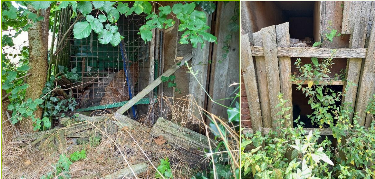
Figuur 2 Details van het schuurtje en materiaalhoop die voor steenmarter toegankelijk zijn
