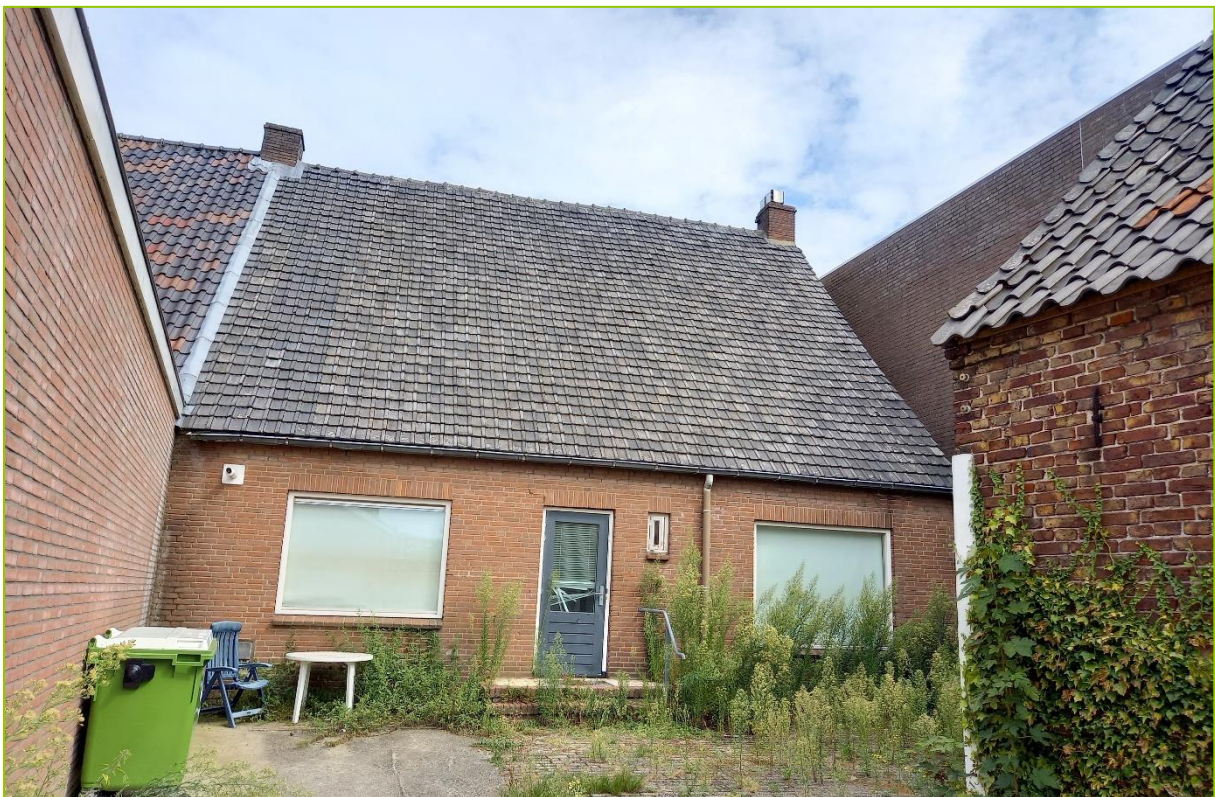
De bebouwing in het plangebied heeft een zadeldak en is voornamelijk opgetrokken uit gemetselde gevels.
