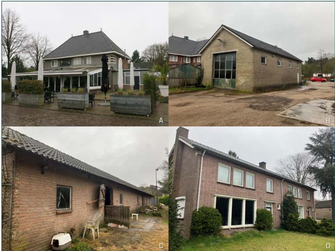
Figuur 1.3 Op de planlocatie is men voornemens om een restaurant, twee schuren, twee woningen en verschillende kleine opstallen te slopen.
