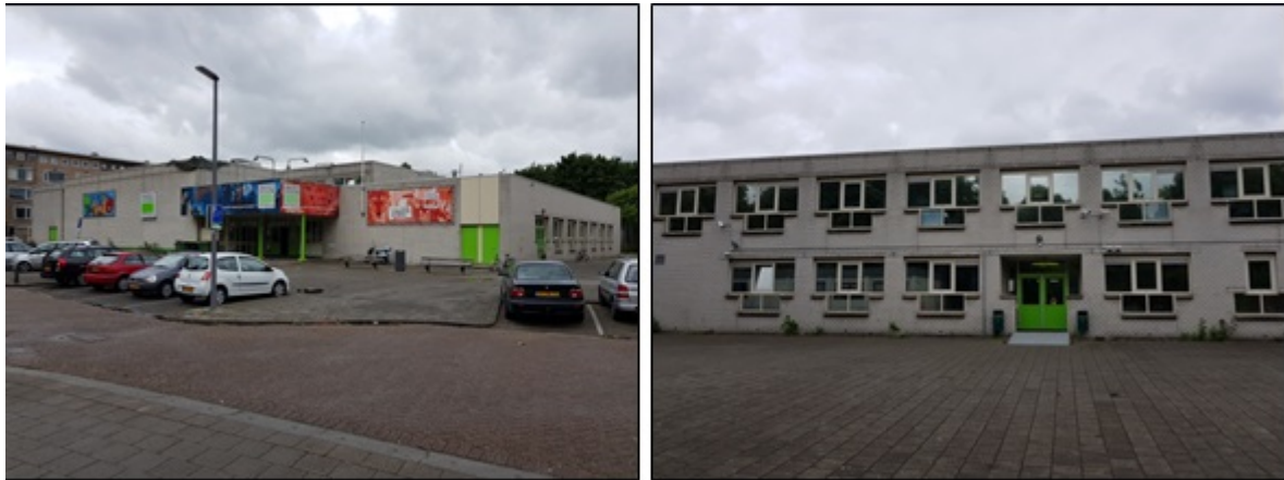
Figuur 3.1: Foto's bestaande situatie; zuidzijde (links) en noordzijde (rechts)
