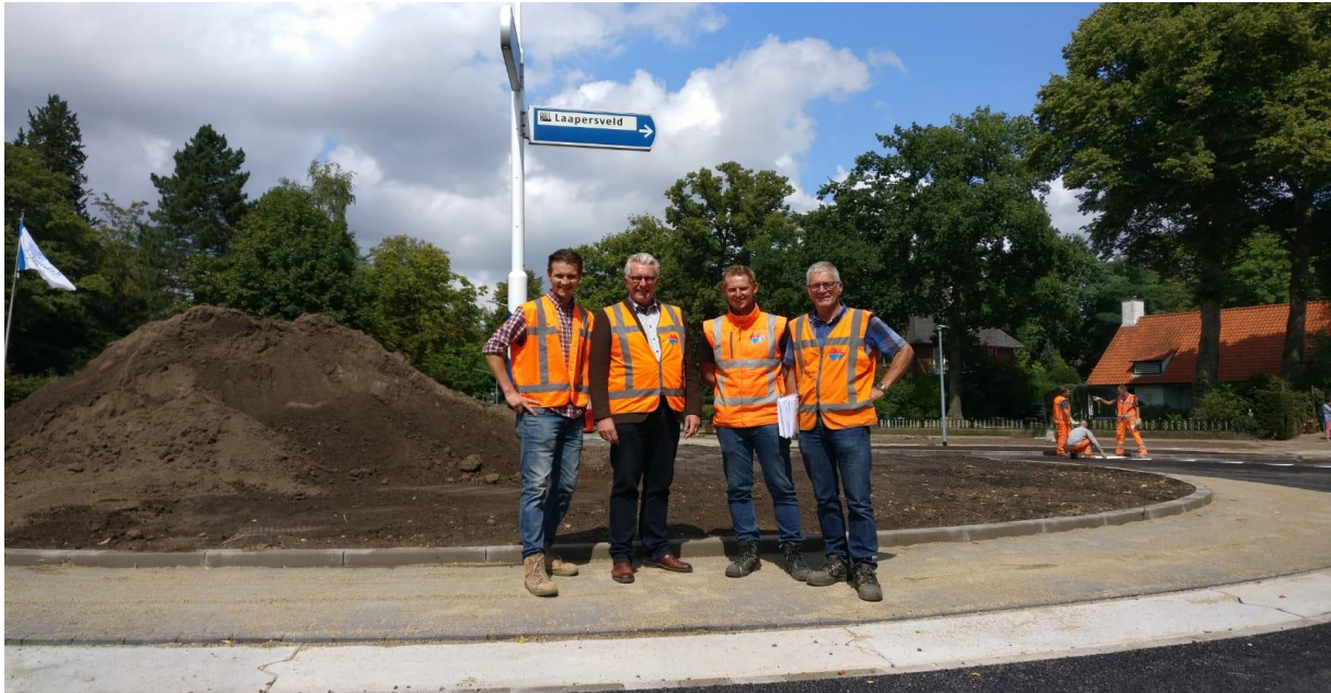
Foto 2: werkzaamheden aan de rotonde Utrechtseweg-Laapersweg-Gijsbrecht van Amstelstraat
