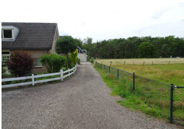
De achterstraat van de Nachtegaalweg is uitgevoerd in grind als halfverharding en er ontbreken lantaarnpalen
