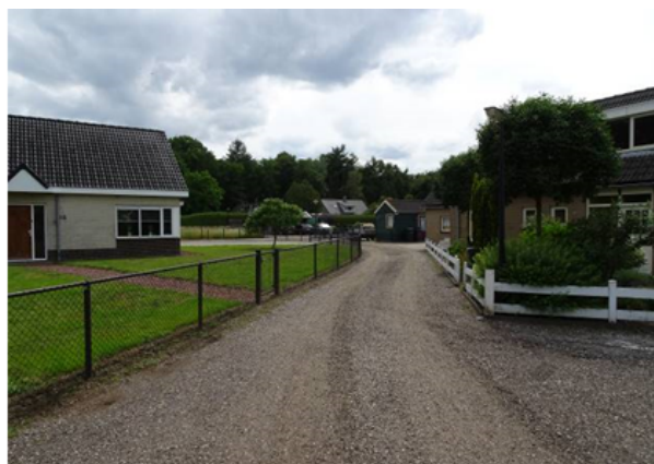
De achterstraat van de Nachtegaalweg is uitgevoerd in grind als halfverharding en er ontbreken lantaarnpalen
