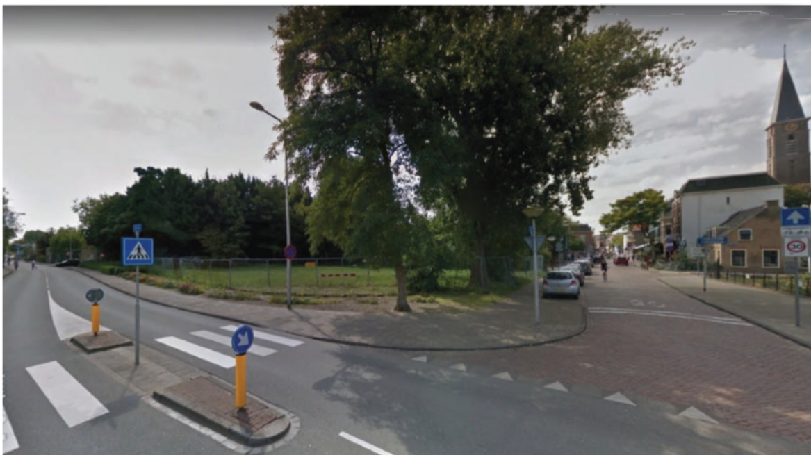
Afbeelding 10 Het plangebied gezien vanuit het noorden; links de Verdilaan, rechts de Dijkweg. Bron: Google Streetview.
