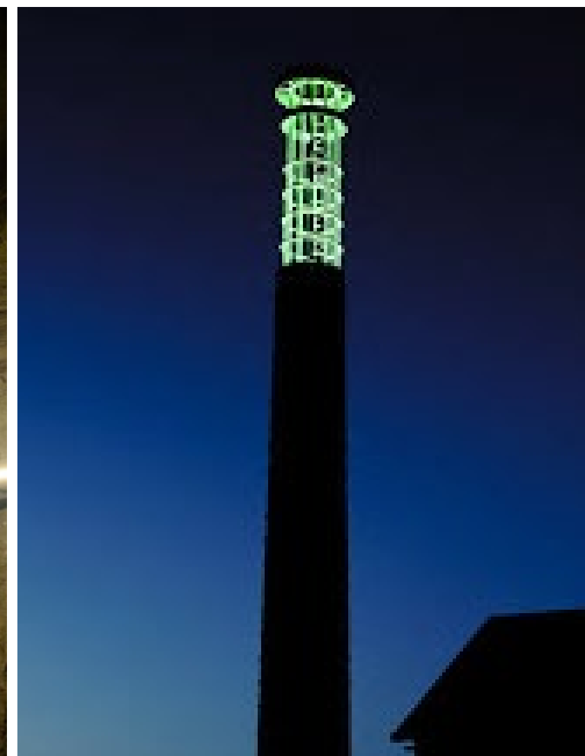
Illuminatie schoorsteen Baken suikerfabriek
