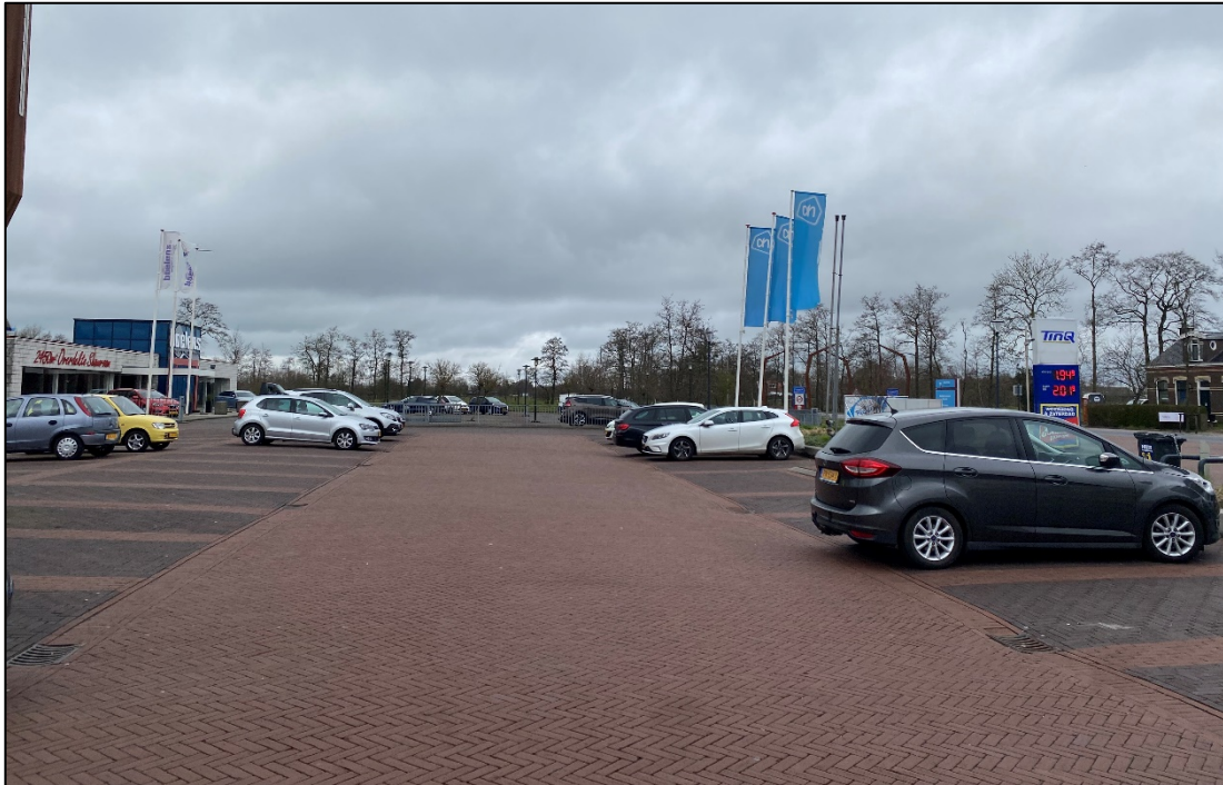
Figuur 5.6: Oostelijk gelegen parkeerterrein
