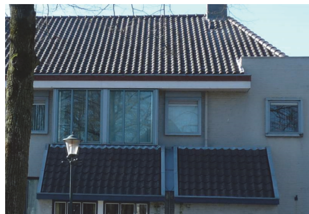
Fig. 4. Detail van het dak, wat geen losliggende dakpannen heeft, en geen sporen van nestvorming in de goot.
