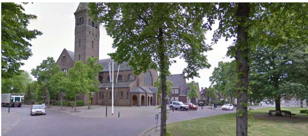
Figuur 3 Weergave van het projectgebied met het voormalige kantoorpand; de aansluiting van het projectgebied op de Dreefstraat; zicht op de Markt en zicht op de Sint-Willibrorduskerk vanuit het projectgebied (Bron: GoogleMaps)
