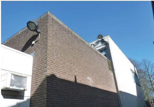
Fig. 7. Zijkant van het pand aan de zuidzijde. Er zijn geen open stoorvoegen
