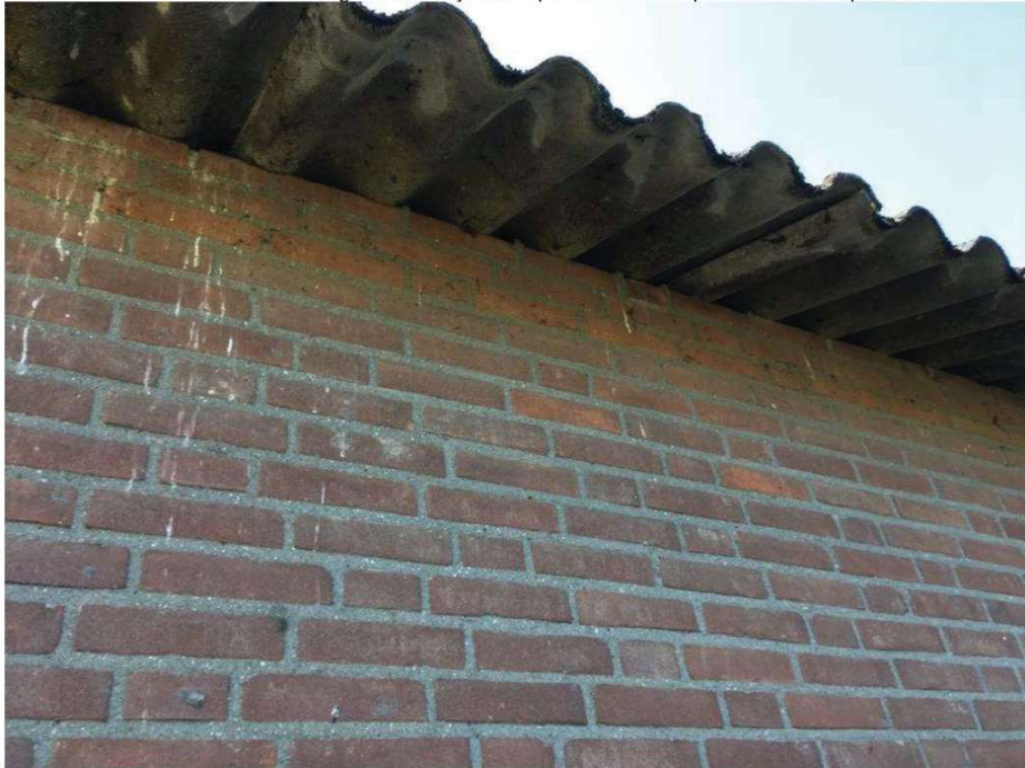
• Afbeelding 15: buitenzijde te slopen schuur met sporen van oude spreuwenest
