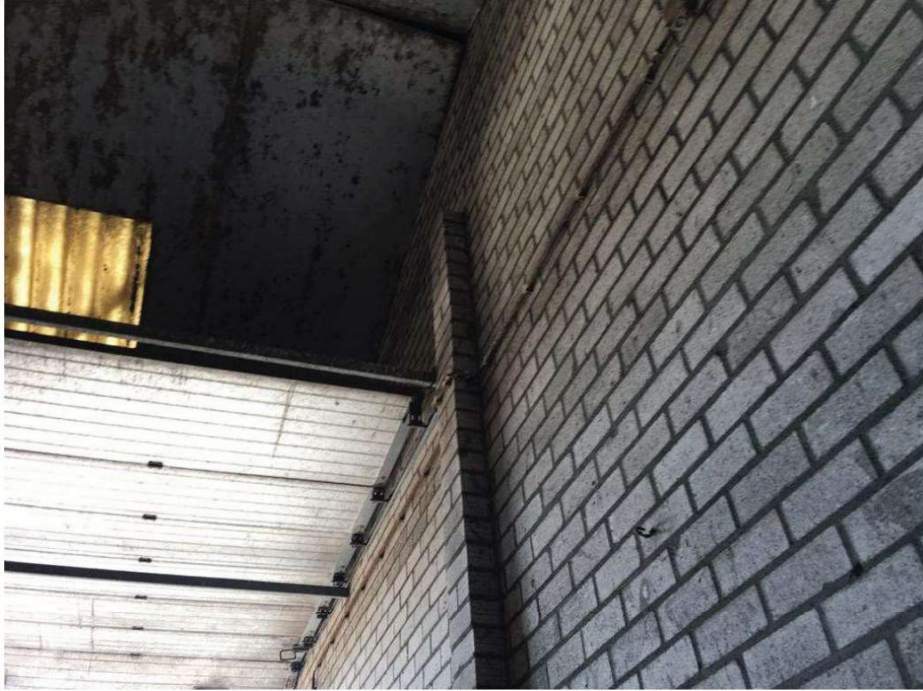
• Afbeelding 11: binnenzijde te slopen schuur
