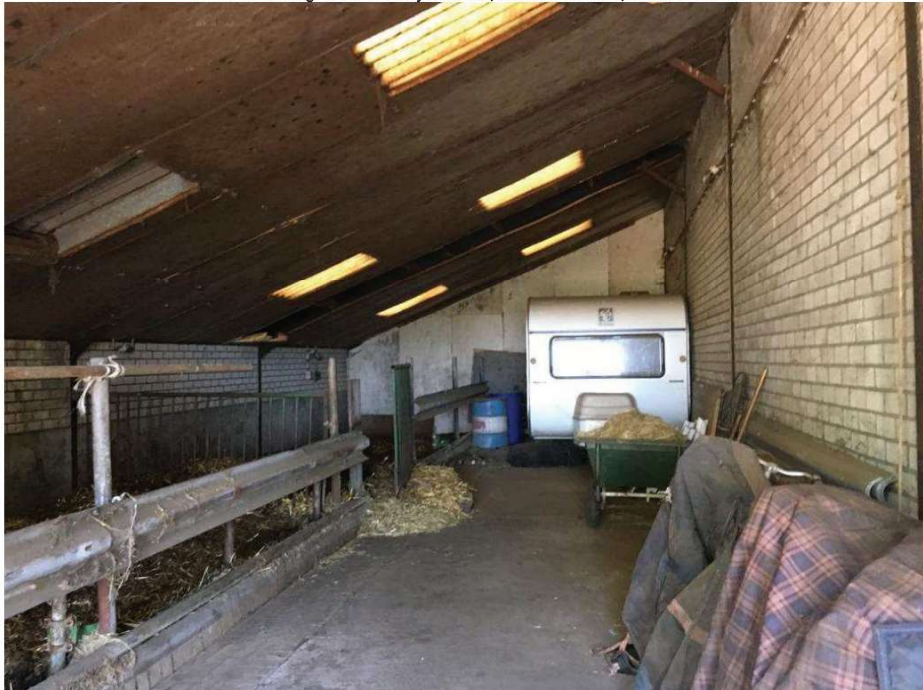
• Afbeelding 16: binnenzijde te slopen schuur met paardenstallen
