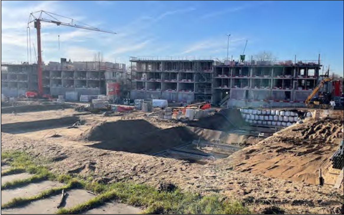
68 nieuwe woningen Berg en Dalseweg 295
