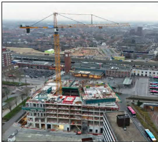
Nieuwe Metterswane in aanbouw
